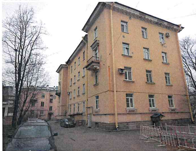
Фото №4 (вход в помещение 8-Н)
