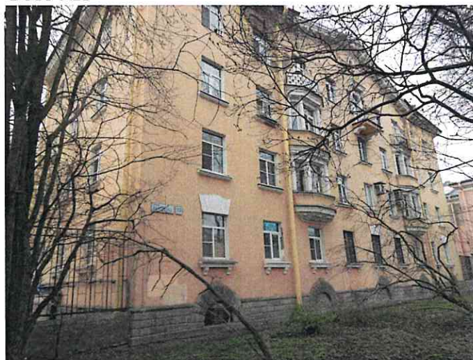
Фото №3 (вход общий со двора)
