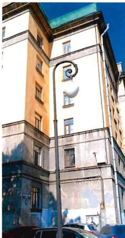
7. Фрагмент. Северный фасад южного флигеля.
