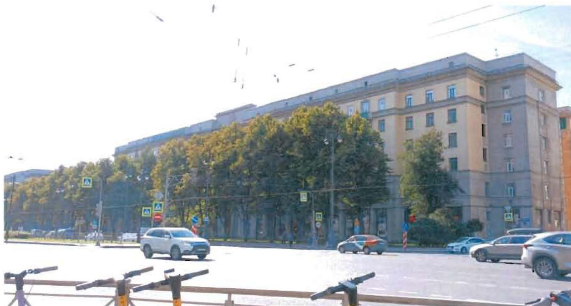
1. Общий вид. Восточный фасад северного флигеля.
