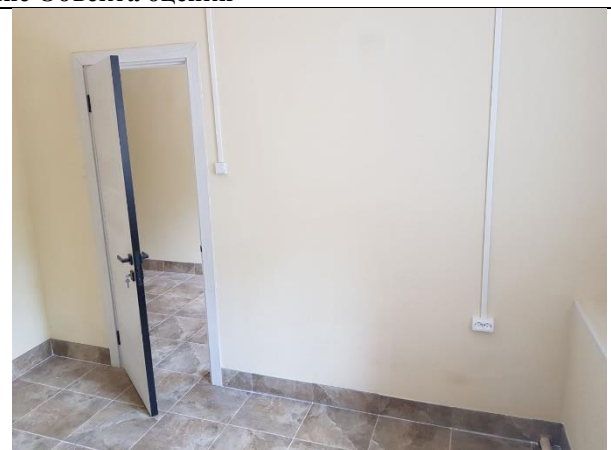
Фото 12. Внутреннее состояние Объекта оценки
