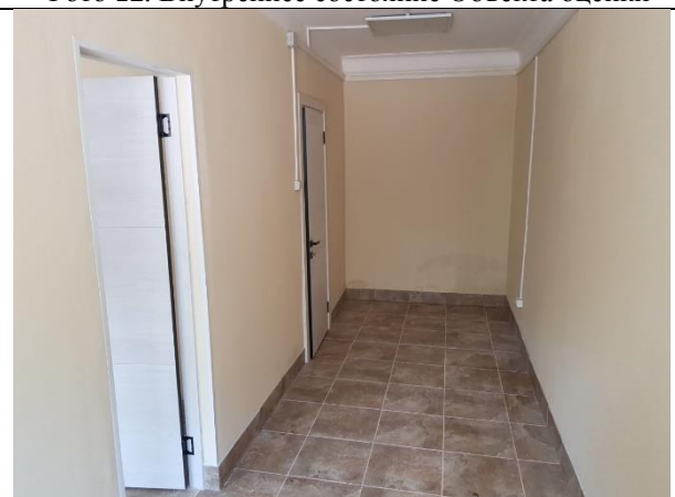
Фото 14. Внутреннее состояние Объекта оценки
