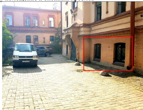
Фото 8. Вид окон Объекта оценки
