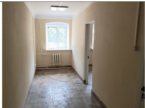
Фото 16. Внутреннее состояние Объекта оценки
