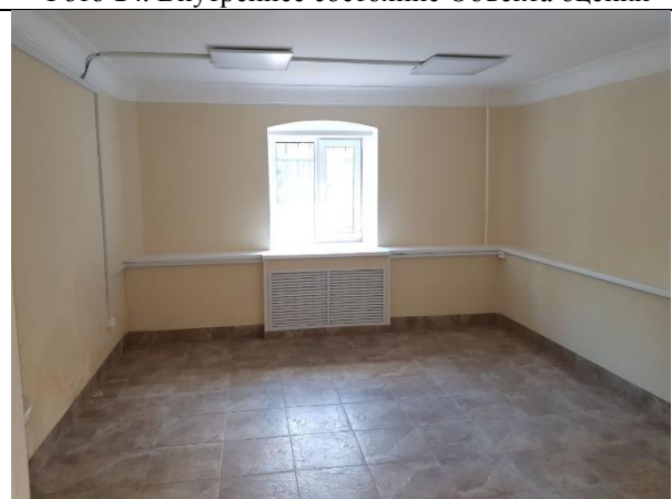
Фото 16. Внутреннее состояние Объекта оценки
