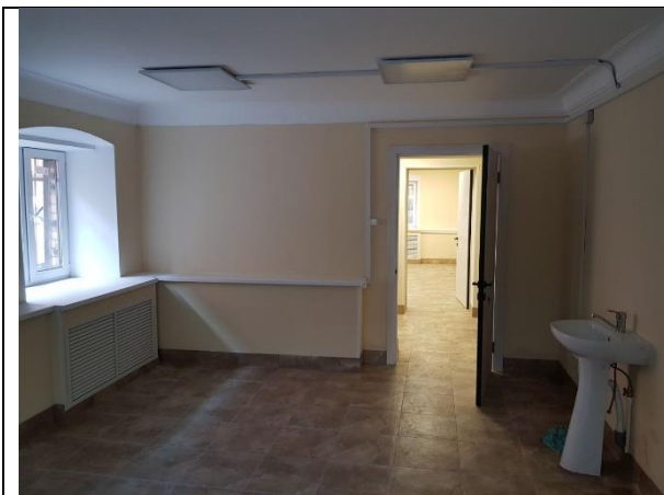
Фото 13. Внутреннее состояние Объекта оценки
