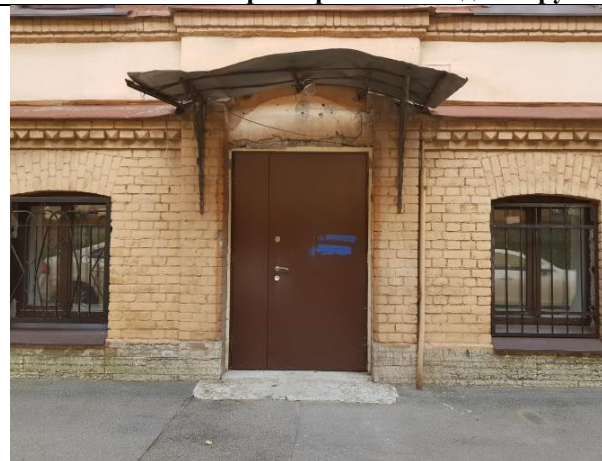
Фото 7. Общий вход с улицы (с торца)
