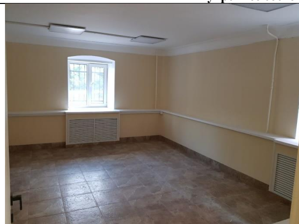
Фото 11. Внутреннее состояние Объекта оценки
