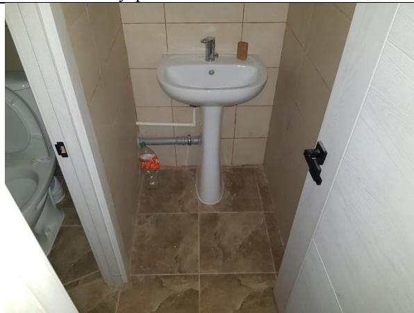
Фото 14. Внутреннее состояние Объекта оценки
