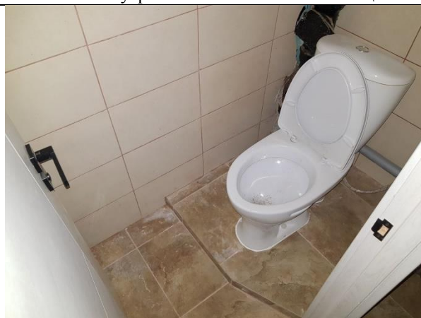
Фото 12. Внутреннее состояние Объекта оценки
