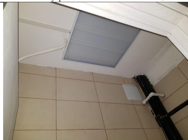
Фото 11. Внутреннее состояние Объекта оценки
