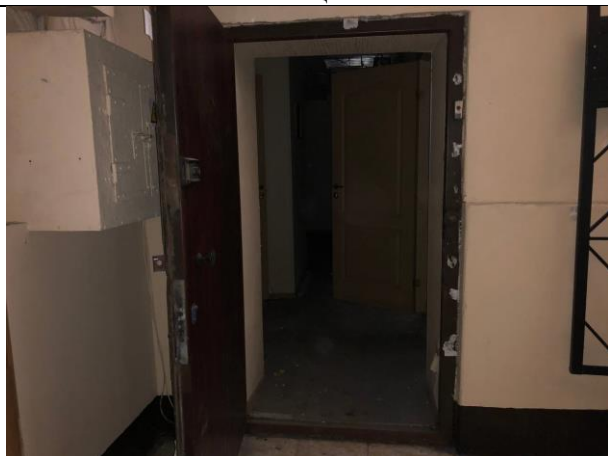
Фото № 9 – Внутреннее состояние помещения
