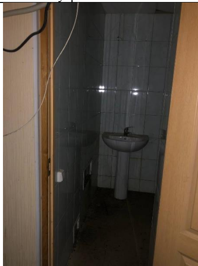
Фото № 14 – Внутреннее состояние помещения
