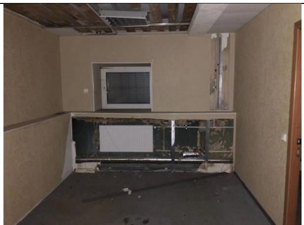
Фото № 18 – Внутреннее состояние помещения
