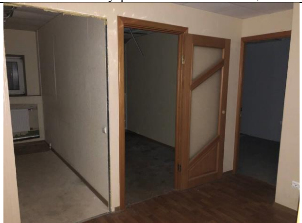
Фото № 20 – Внутреннее состояние помещения
