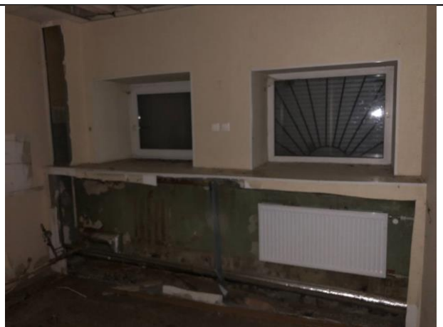
Фото № 12 – Внутреннее состояние помещения
