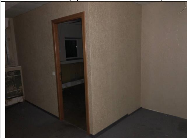
Фото № 19 – Второй вход в помещение
