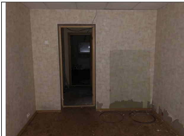
Фото № 11 – Внутреннее состояние помещения
