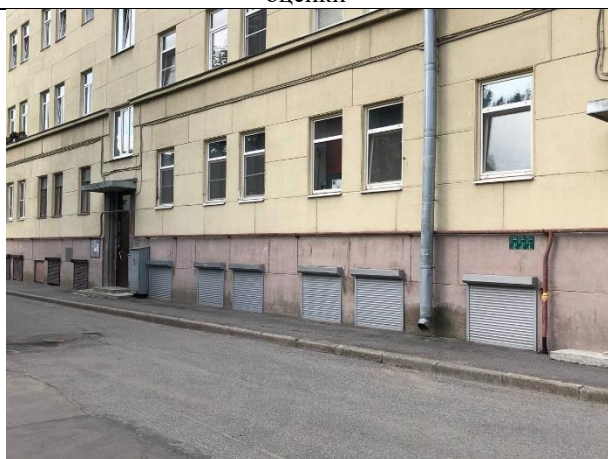
Фото № 5 – Окна помещения
