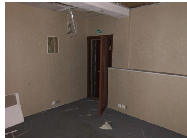
Фото № 17 – Внутреннее состояние помещения
