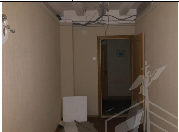
Фото № 24 – Внутреннее состояние помещения
