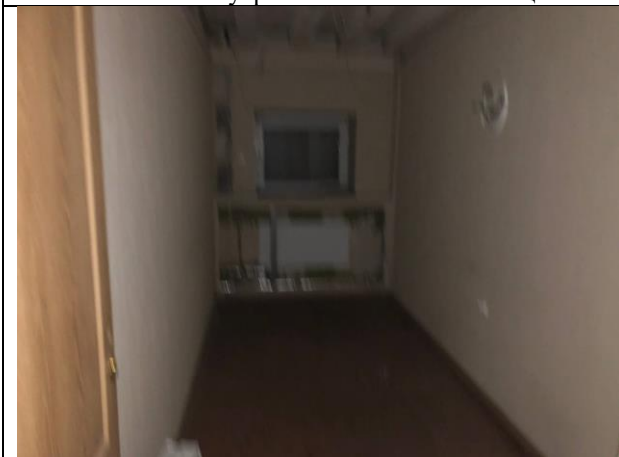
Фото № 23 – Внутреннее состояние помещения
