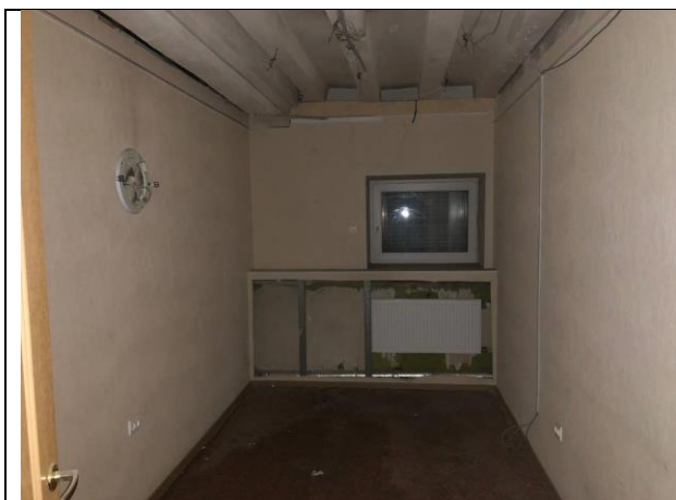
Фото № 25 – Внутреннее состояние помещения
