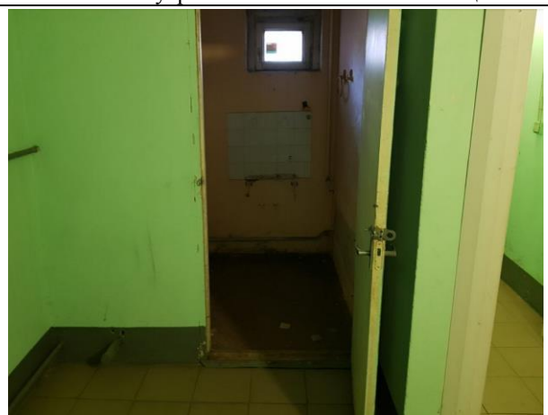
Фото 12. Внутреннее состояние Объекта оценки
