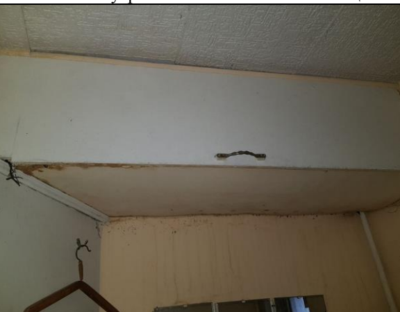
Фото 16. Внутреннее состояние Объекта оценки
