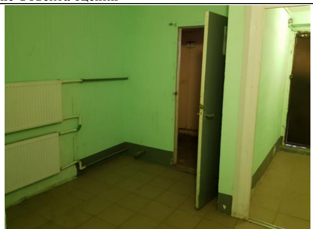
Фото 10. Внутреннее состояние Объекта оценки
