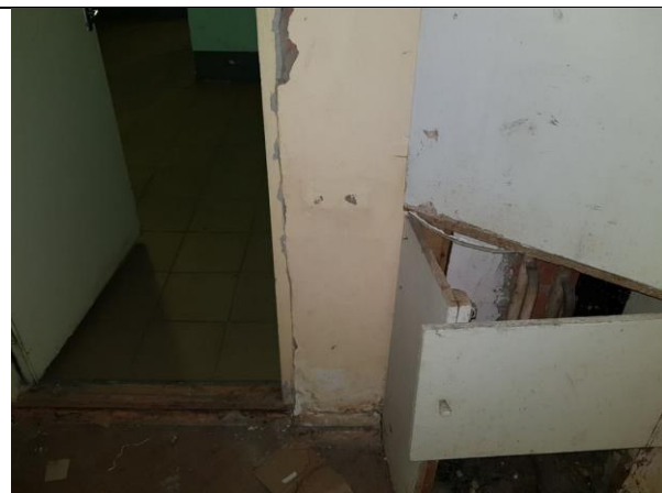
Фото 13. Внутреннее состояние Объекта оценки
