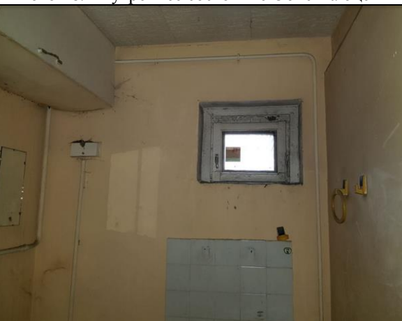
Фото 18. Внутреннее состояние Объекта оценки
