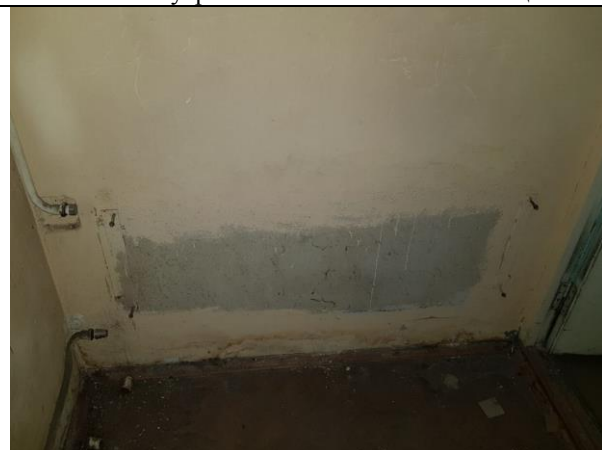
Фото 15. Внутреннее состояние Объекта оценки
