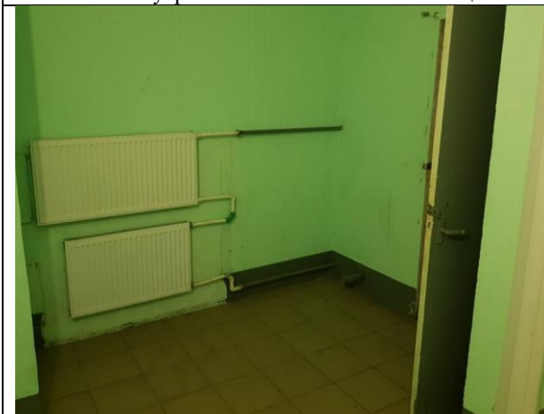
Фото 11. Внутреннее состояние Объекта оценки
