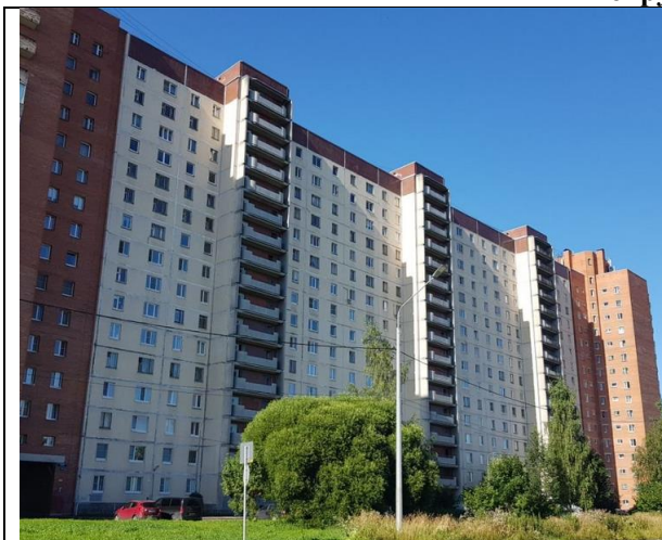
Фото 1. Вид здания, в котором расположен Объект оценки
