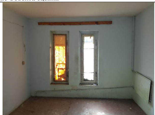
Фото 10. Внутреннее состояние Объекта оценки
