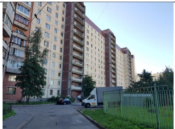
Фото 2. Вид здания, в котором расположен Объект оценки
