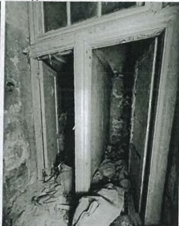
7.13, 7.14. Помещение 1-Н, ч.п. 5, 7. Загрязнения, деструкция отделочных слоев
