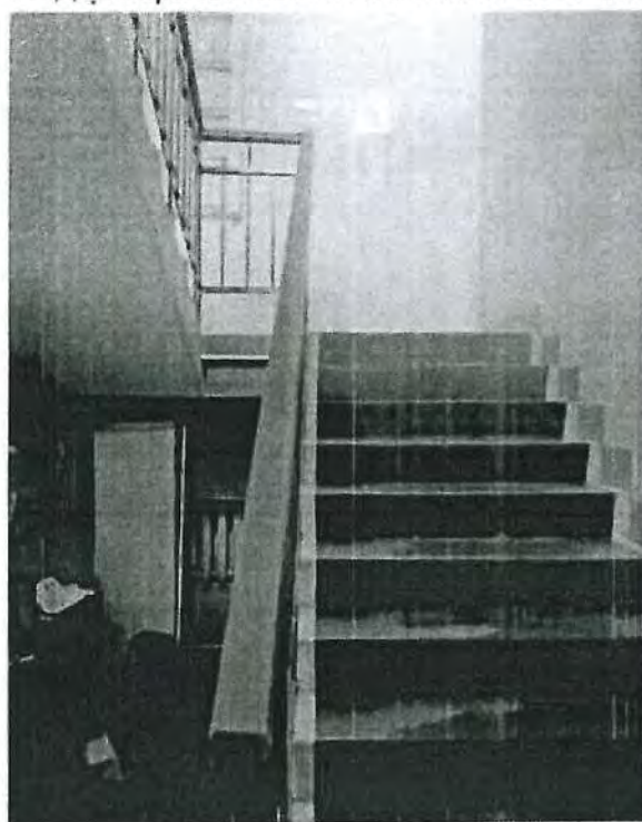
21. Двухмаршевая лестница в южной части здания. 22. Конструкции крыши.
