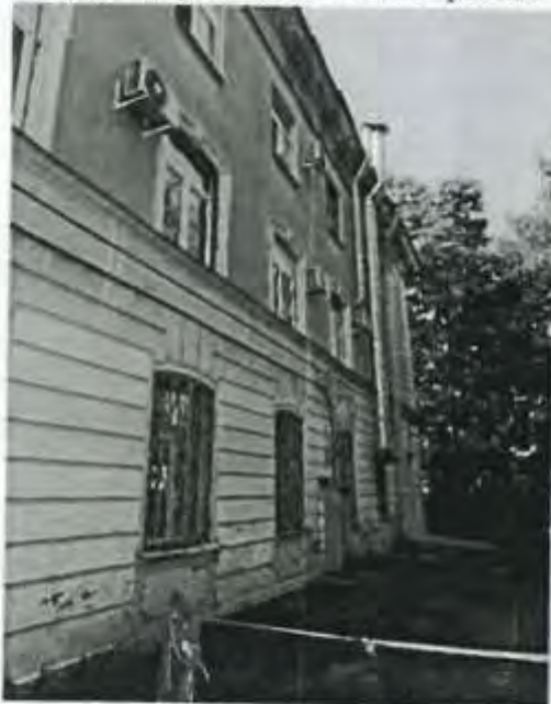
6.11. Фрагмент восточного фасада. Крыльцо. 6.12. Фрагмент восточного и южного фасадов. Утраты окрасочного слоя. Кондиционеры.
