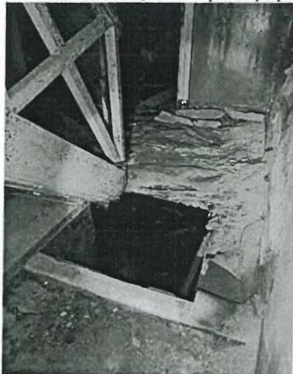
7.15. Помещение 1-Н, ч.п. 1. Утрата перекрытия. 7.16. Одномаршевая лестница.
