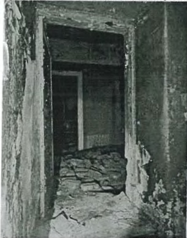
7.13, 7.14. Помещение 1-Н, ч.п. 5, 7. Загрязнения, деструкция отделочных слоев
