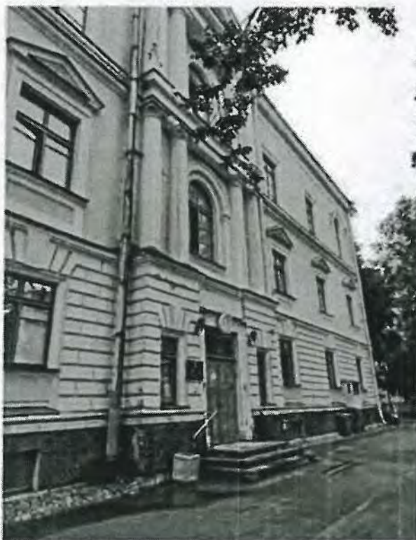
1.7. Центральная часть северного фасада.
