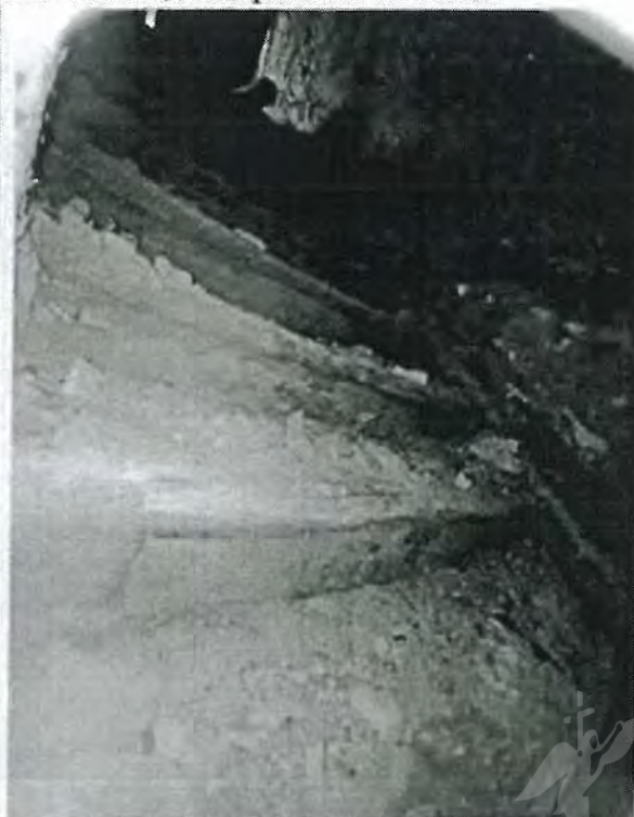
7.15. Помещение 1-Н, ч.п. 1. Утрата перекрытия. 7.16. Одномаршевая лестница.
