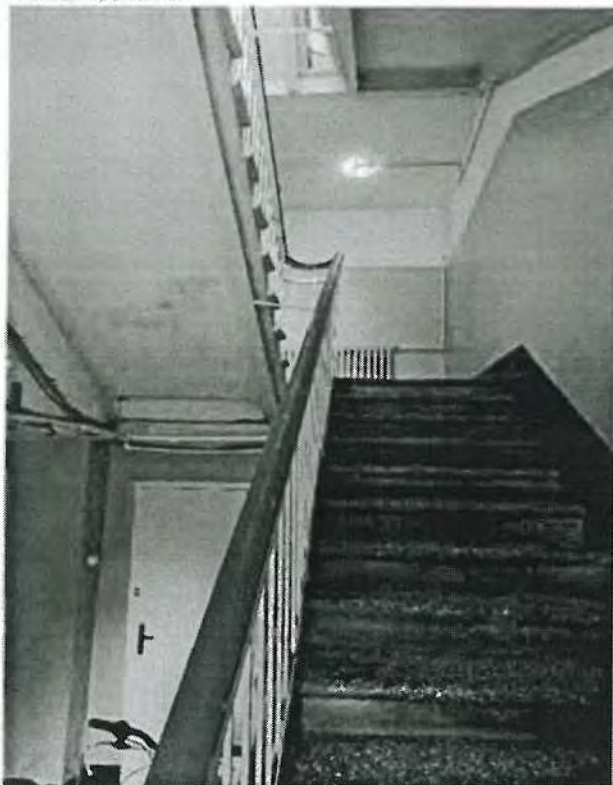
6.21. Двухмаршевая лестница в восточной части здания.
