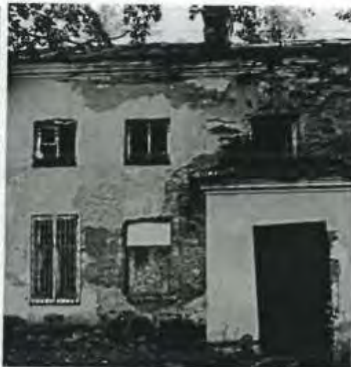
7.6. Фрагмент южного фасада.
