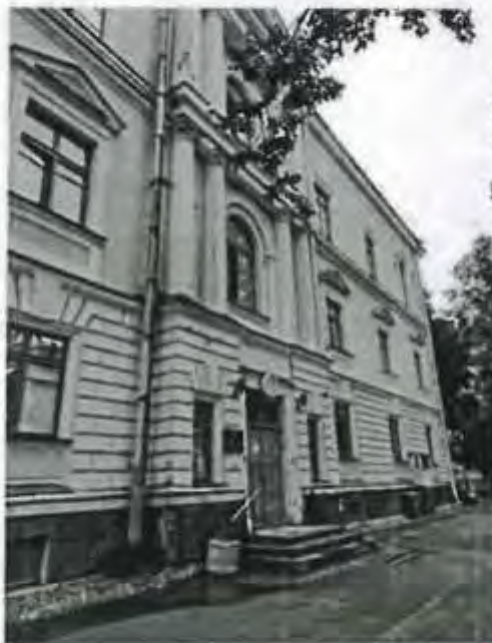
1.7. Центральная часть северного фасада.
