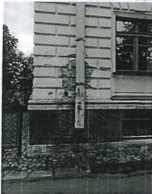
1.15, 1.16. Фрагменты северного фасада, утрата элемента слива, биопоражения. Крыльцо.
