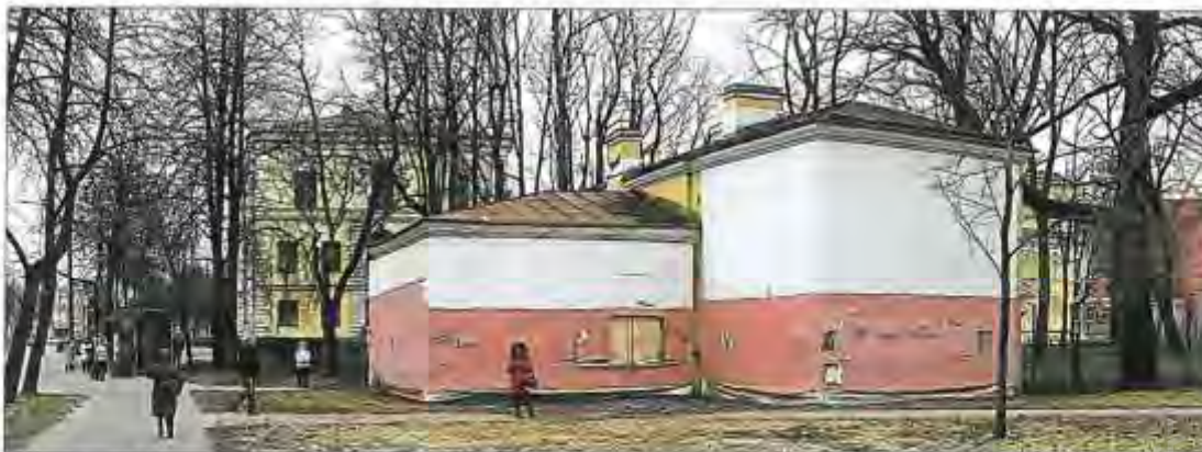
Фото 1. Вид на Объект со стороны Санкт-Петербургского проспекта (на северо-западный угол здания)
