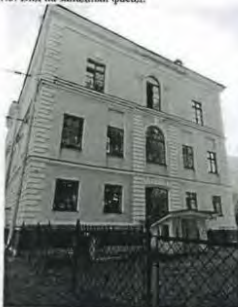
1.5. Вид на западный фасад.
