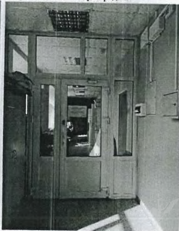
6.20. Помещение 1-Н, ч.п. 9 (3 этаж). Устройство новой перегородки.
