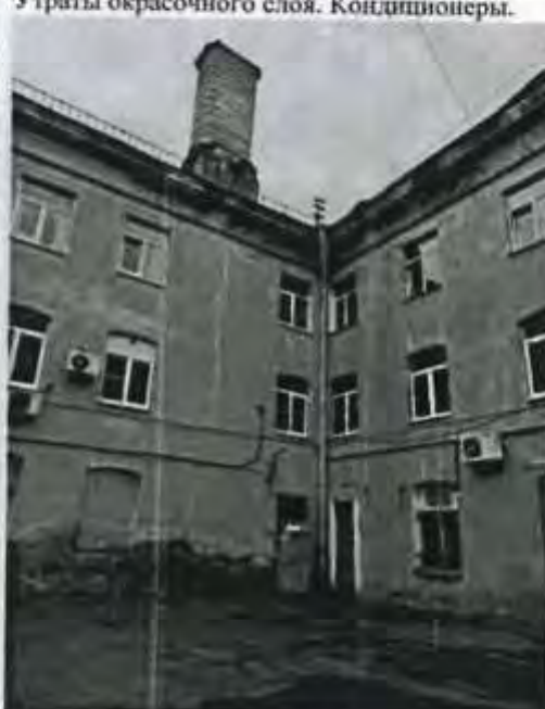
6.11. Фрагмент восточного фасада. Крыльцо. 6.12. Фрагмент восточного и южного фасадов. Утраты окрасочного слоя. Кондиционеры.
