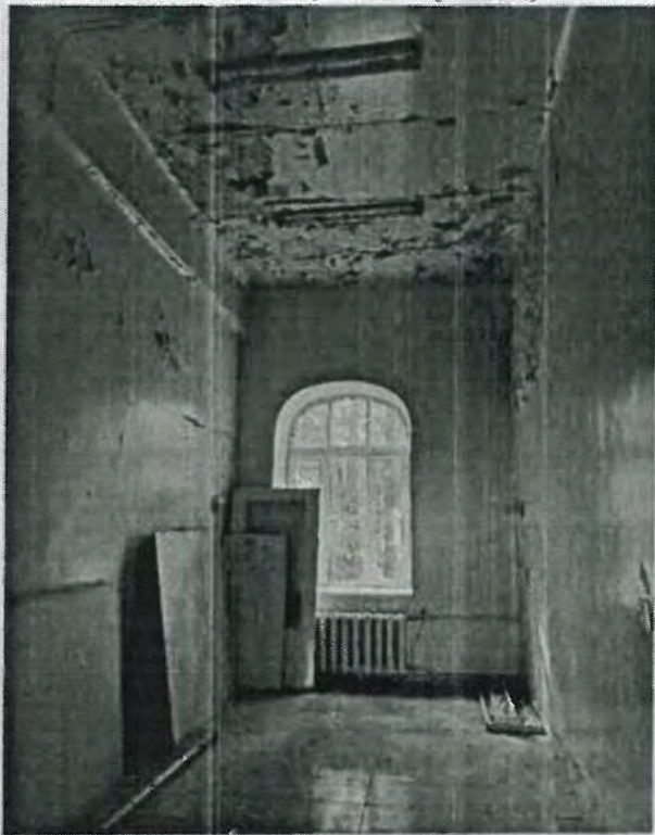
3.21. Помещение 1-Н, ч.п. 57 (2 этаж).
