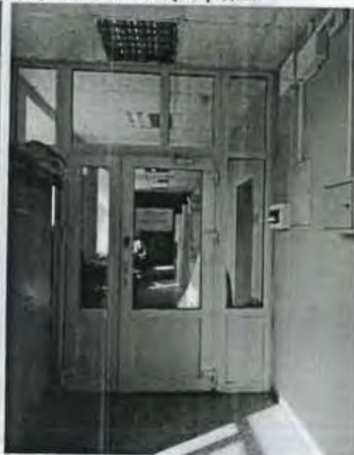
6.20. Помещение 1-Н, ч.п. 9 (3 этаж). Устройство новой перегородки.
