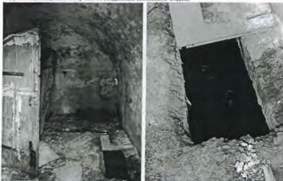
4.5, 4.6. Помещение 1-Н, ч.п. 1. Подполье затоплено водой.
