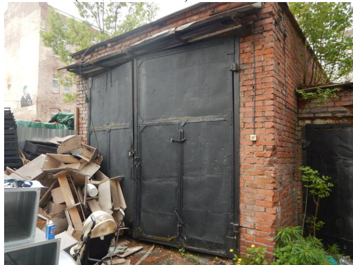
Фото №4 (ч.п.1 пом.2-Н)
