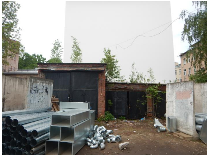
Фото №3 (вход в пом.2-Н,3-Н)
