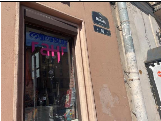
Фото 15. Адрес Объекта оценки
