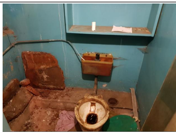
Фото 20. Внутреннее состояние Объекта оценки
