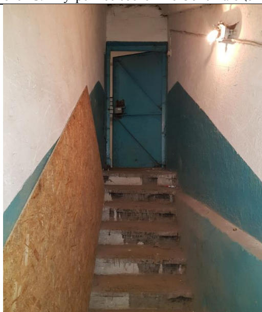
Фото 15. Внутреннее состояние Объекта оценки
