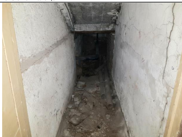
Фото 10. Внутреннее состояние Объекта оценки
