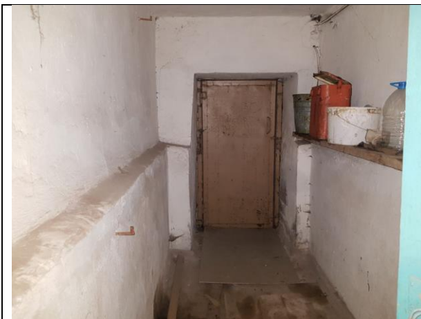
Фото 13. Внутреннее состояние Объекта оценки
