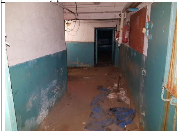
Фото 11. Внутреннее состояние Объекта оценки
