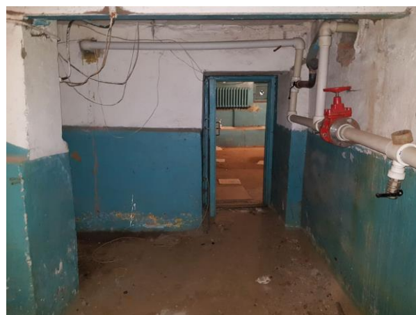
Фото 16. Внутреннее состояние Объекта оценки
