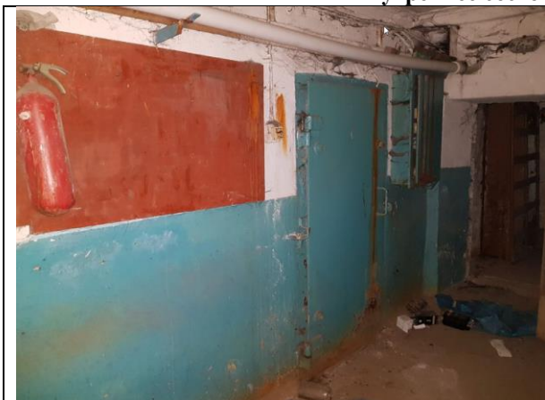
Фото 9. Внутреннее состояние Объекта оценки
