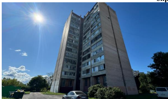
Фото 1. Вид здания Объекта оценки
