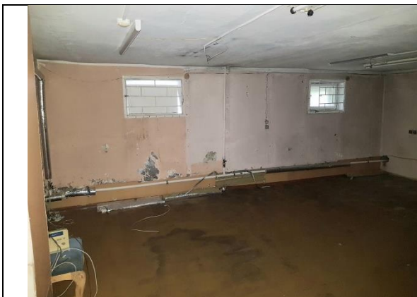
Фото 19. Внутреннее состояние Объекта оценки
