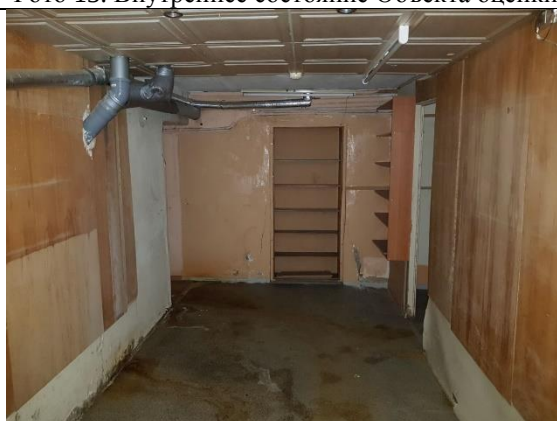
Фото 15. Внутреннее состояние Объекта оценки
