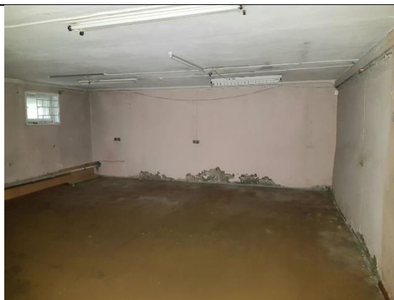
Фото 20. Внутреннее состояние Объекта оценки
