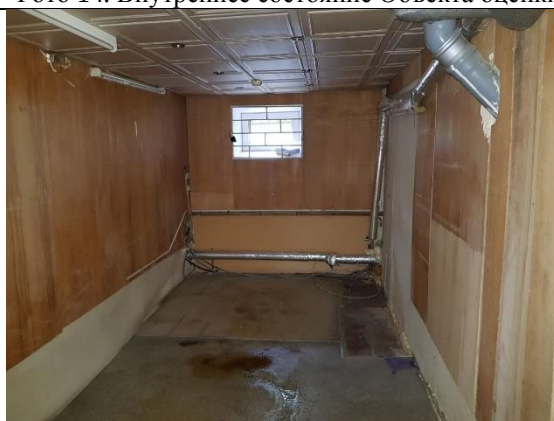
Фото 16. Внутреннее состояние Объекта оценки
