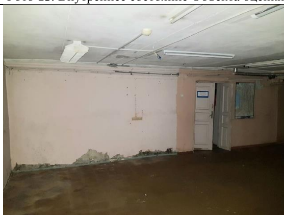
Фото 17. Внутреннее состояние Объекта оценки
