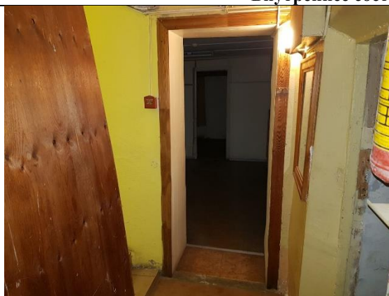
Фото 11. Внутреннее состояние Объекта оценки
