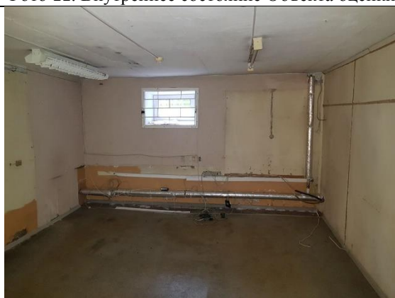
Фото 13. Внутреннее состояние Объекта оценки
