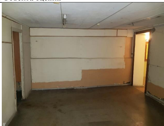
Фото 12. Внутреннее состояние Объекта оценки
