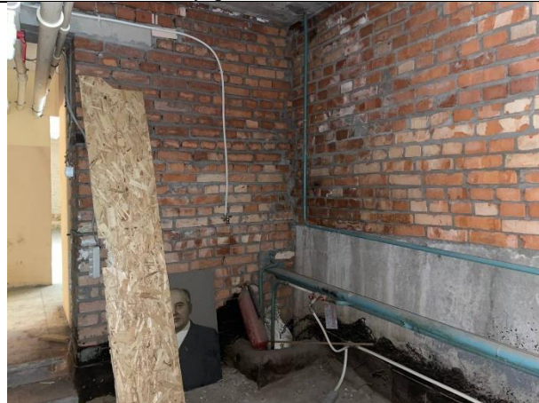
Фото № 32 – Внутреннее состояние помещения
