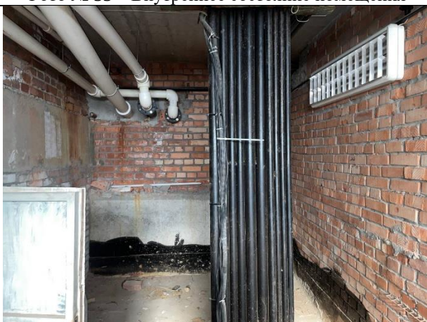
Фото № 35 – Внутреннее состояние помещения
