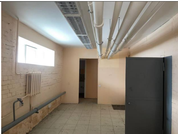
Фото № 37 – Внутреннее состояние помещения
