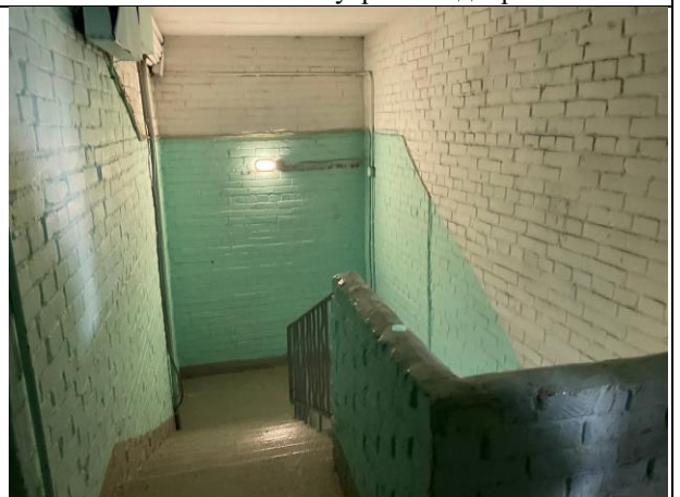
Фото № 10 – Лестничная клетка
