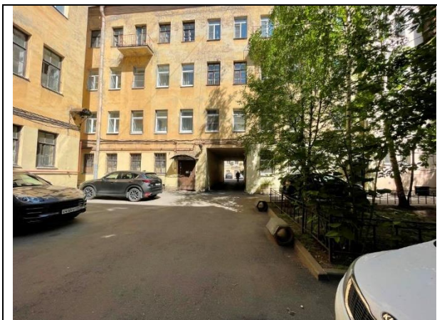
Фото 15. Внутриворовая территория Объекта оценки
