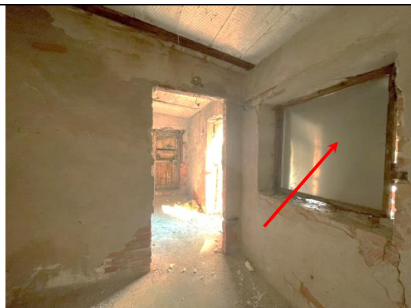
Фото 30. Типичное состояние Объекта оценки, оконная группа Объекта оценки
