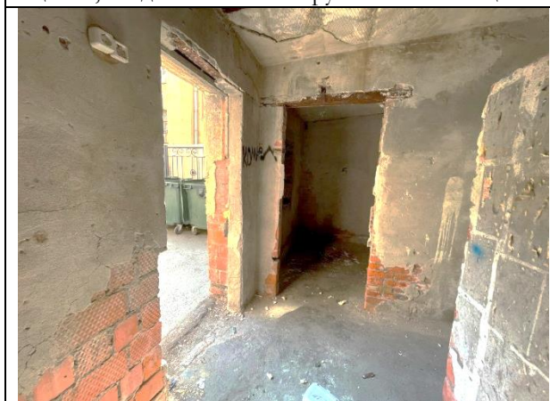
Фото 27. Типичное состояние Объекта оценки
