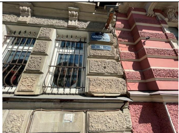
Фото 12. Адрес Объекта оценки
