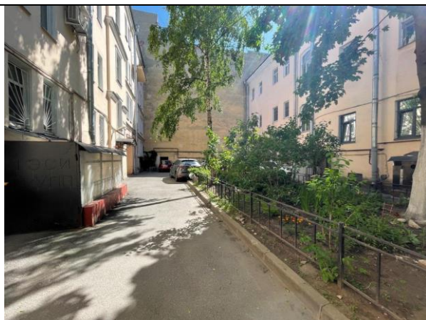
Фото 16. Внутриворовая территория Объекта оценки
