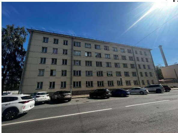
Фото 1. Вид здания, в котором расположен Объект оценки
