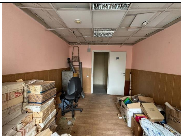
Фото № 10 – Внутреннее состояние помещения
