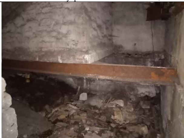
Фото № 29 – Внутреннее состояние помещения
