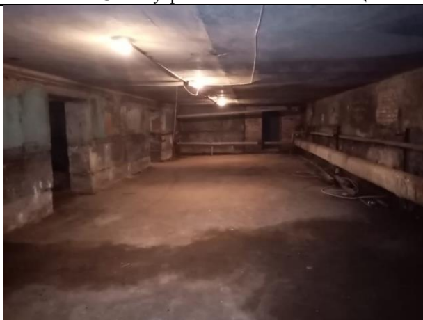
Фото № 27 – Внутреннее состояние помещения
