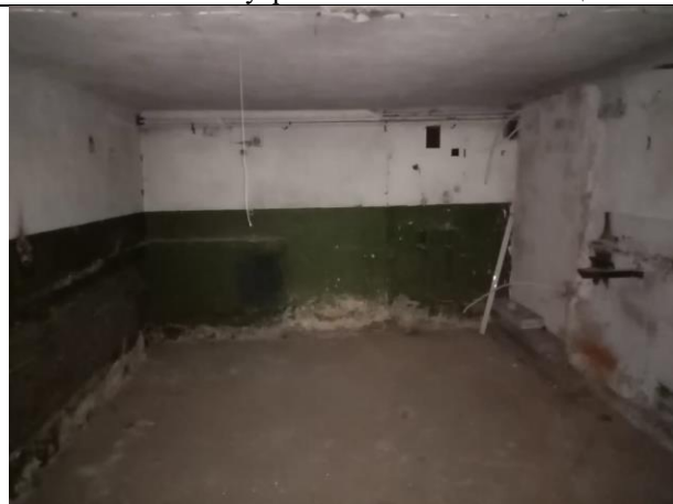
Фото № 26 – Внутреннее состояние помещения
