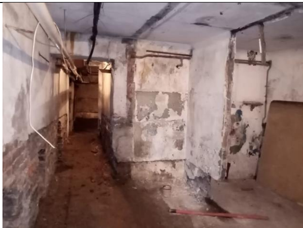
Фото № 7 – Внутреннее состояние помещения
