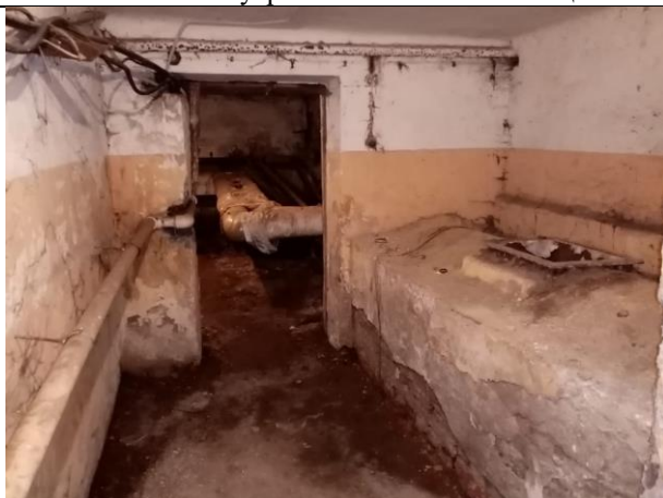
Фото № 13 – Внутреннее состояние помещения
