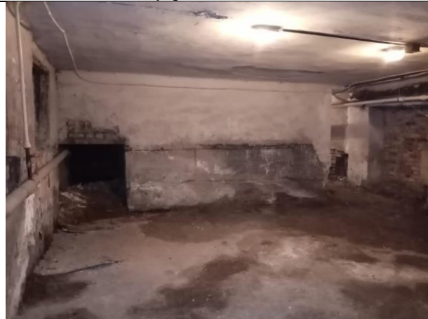
Фото № 18 – Внутреннее состояние помещения
