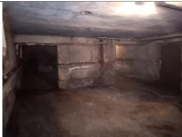
Фото № 32 – Внутреннее состояние помещения
