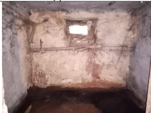
Фото № 10 – Внутреннее состояние помещения
