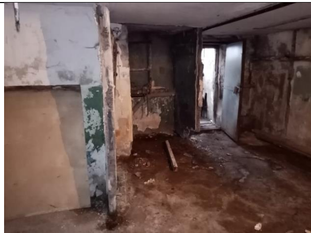
Фото № 8 – Внутреннее состояние помещения
