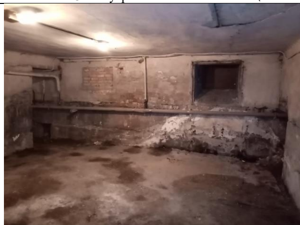
Фото № 20 – Внутреннее состояние помещения
