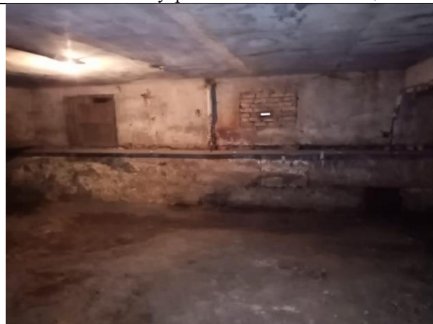
Фото № 34 – Внутреннее состояние помещения
