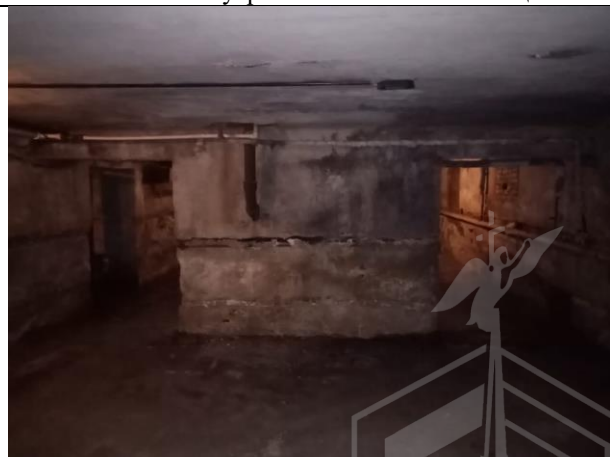
Фото № 30 – Внутреннее состояние помещения
