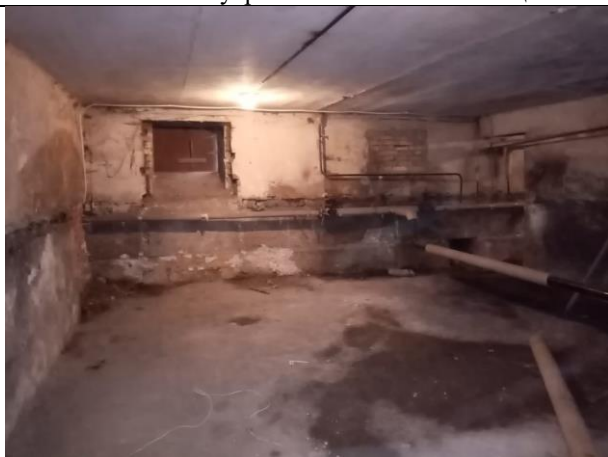
Фото № 21 – Внутреннее состояние помещения
