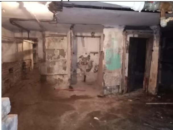
Фото № 9 – Внутреннее состояние помещения
