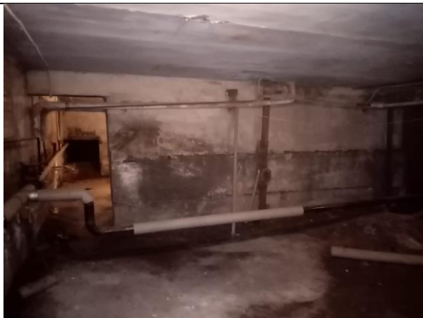
Фото № 23 – Внутреннее состояние помещения
