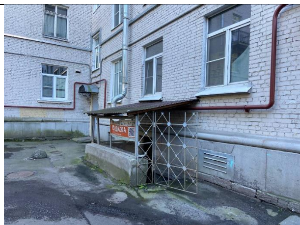
Фото № 4 – Вход в помещение
