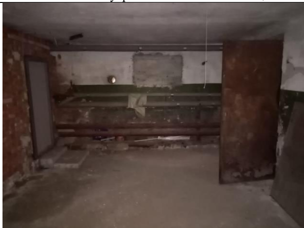
Фото № 25 – Внутреннее состояние помещения
