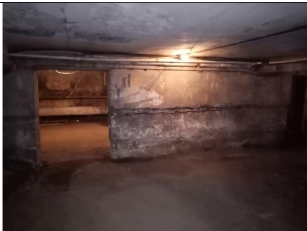
Фото № 31 – Внутреннее состояние помещения
