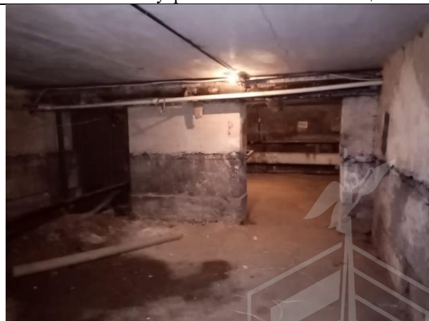
Фото № 22 – Внутреннее состояние помещения
