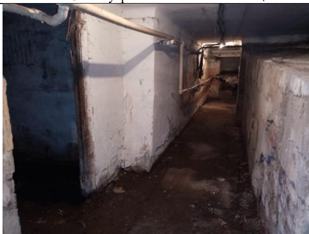
Фото № 11 – Внутреннее состояние помещения
