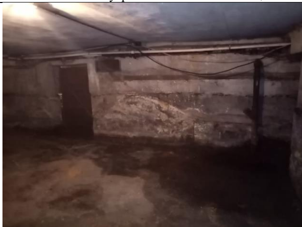
Фото № 33 – Внутреннее состояние помещения
