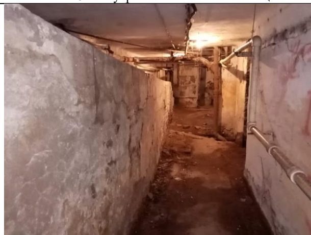
Фото № 12 – Внутреннее состояние помещения
