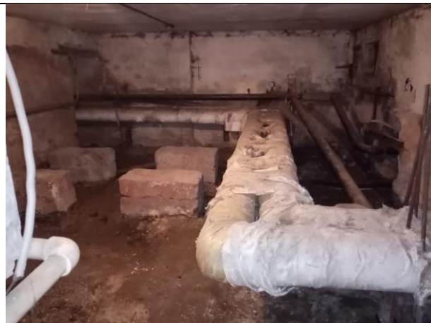
Фото № 16 – Внутреннее состояние помещения
