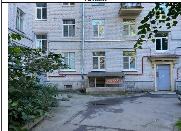
Фото № 3 – Вход в помещение
