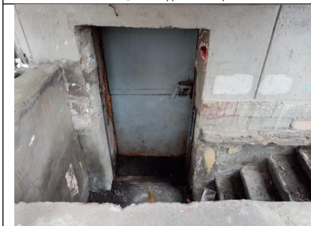
Фото № 5 – Вход в помещение
