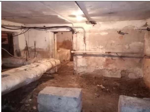
Фото № 15 – Внутреннее состояние помещения
