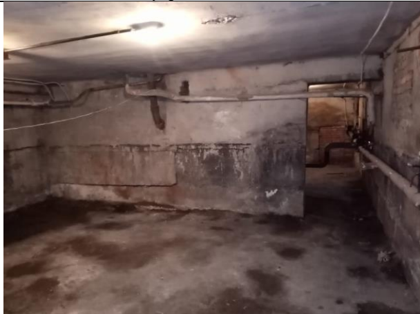
Фото № 17 – Внутреннее состояние помещения
