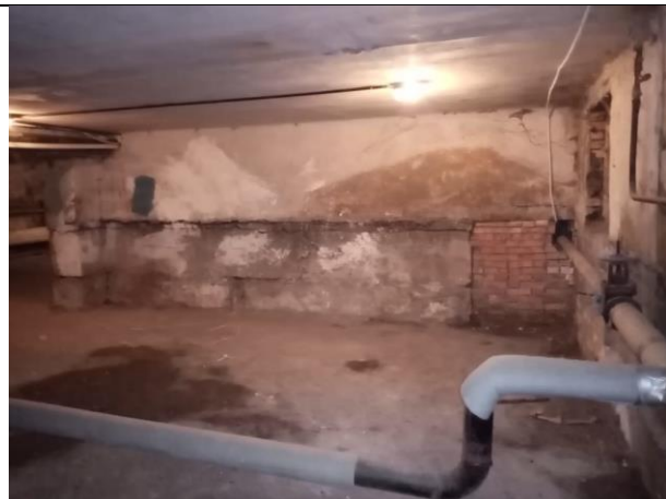
Фото № 24 – Внутреннее состояние помещения
