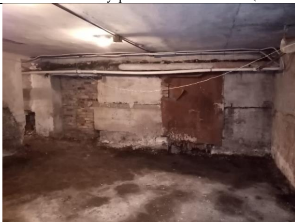
Фото № 19 – Внутреннее состояние помещения
