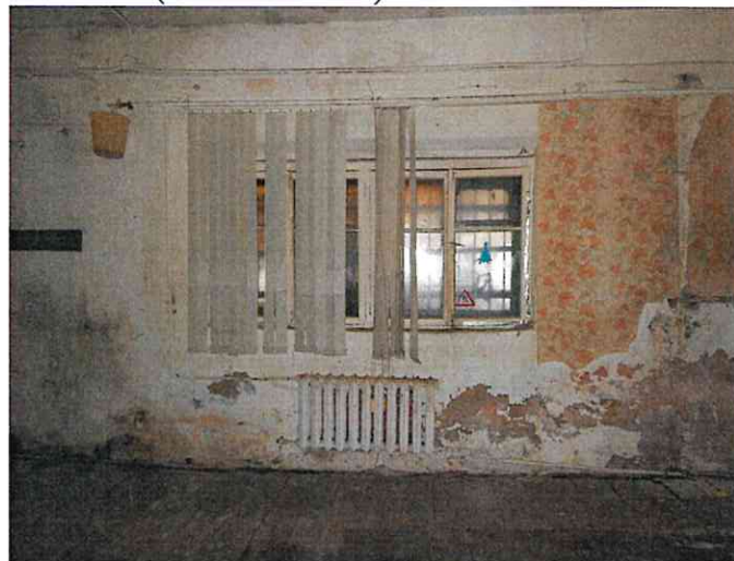
Фото №10 (ч.п.3 пом. 1-Н)
