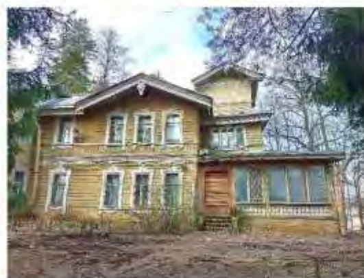
Фото 31. Вид на правую часть восточного фасада и вход в ч.п.1 (тамбур) пом.1-Н
