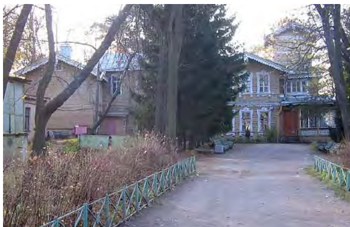
Фото 15. Восточный фасад (2010-е гг.)
