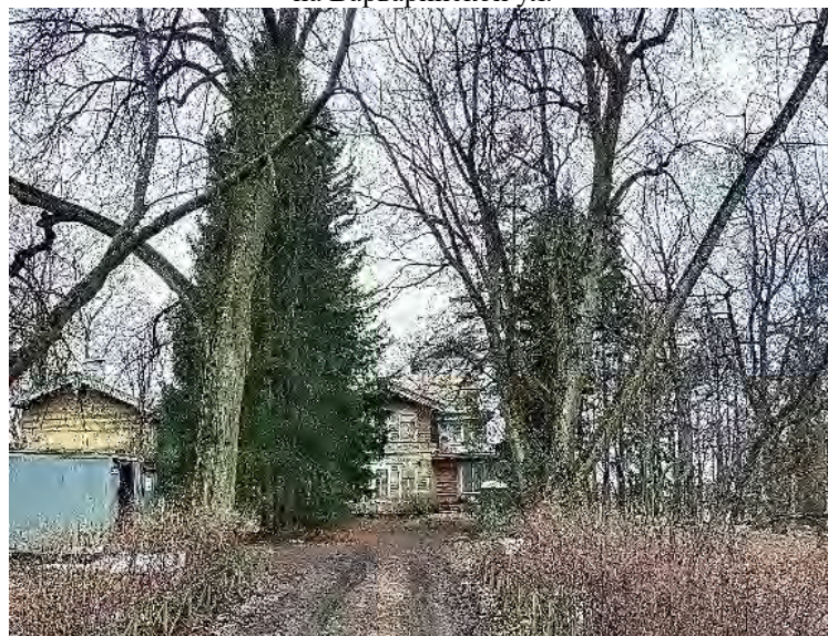
Фото 22. Вид на восточный фасад
