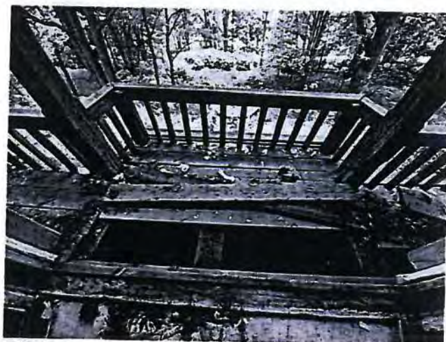
28. Трехчастный балкон западного фасада объекта культурного наследия
