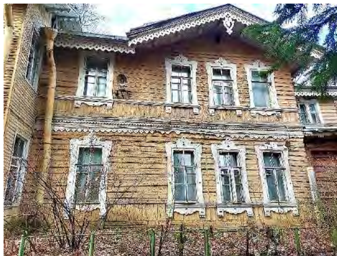
Фото 27. Вид на центральную часть восточного фасада
