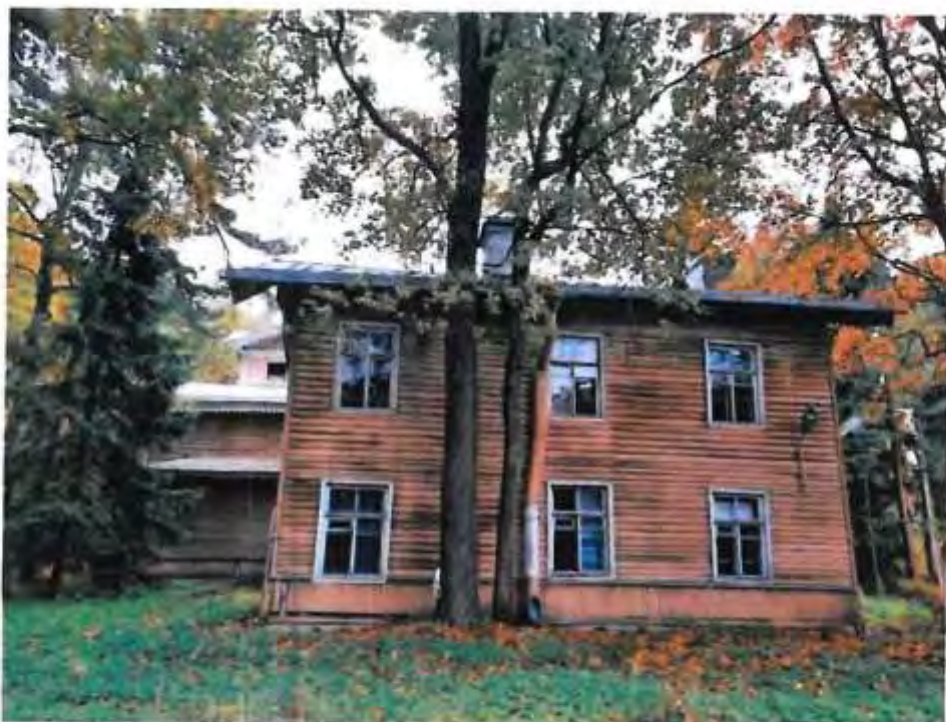
4. Вид на южный фасад объекта культурного наследия
