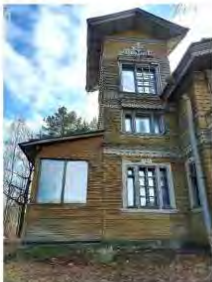
Фото 37. Вид на левую часть западного фасада
