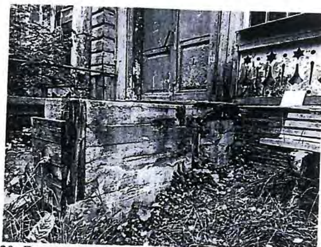
20. Деревянное крыльцо восточного фасада объекта культурного наследия
