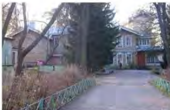
Фото 15. Восточный фасад (2010-е гг.)
