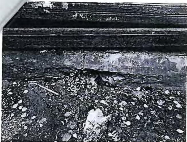
7. Фрагмент северного фасада объекта культурного наследия. Состояние цоколя
