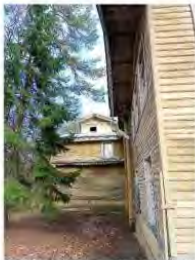
Фото 41. Вид с юго-западного угла ОКН
