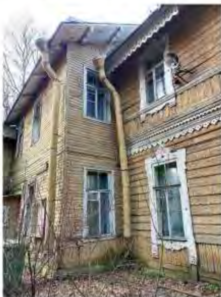
Фото 28. Вид на центральную часть восточного фасада
