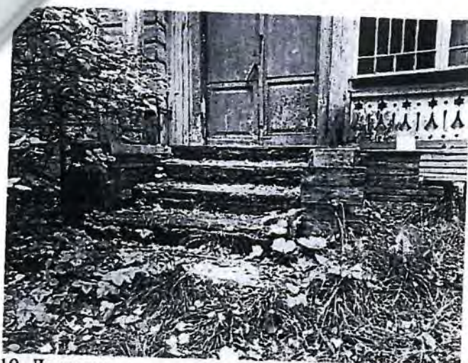
19. Деревянное крыльцо восточного фасада объекта культурного наследия
