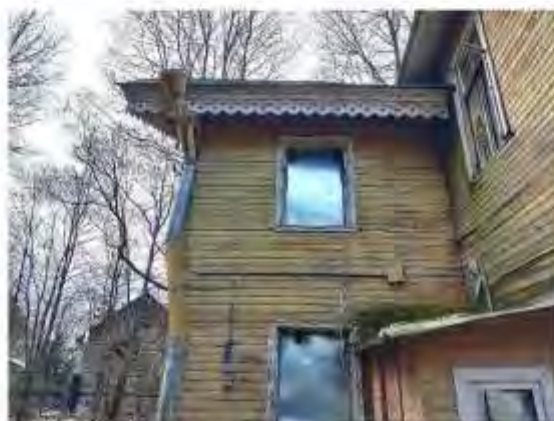
Фото 26. Вид на часть восточного фасада возле входа в ч.п.19 (тамбур) пом.1-Н
