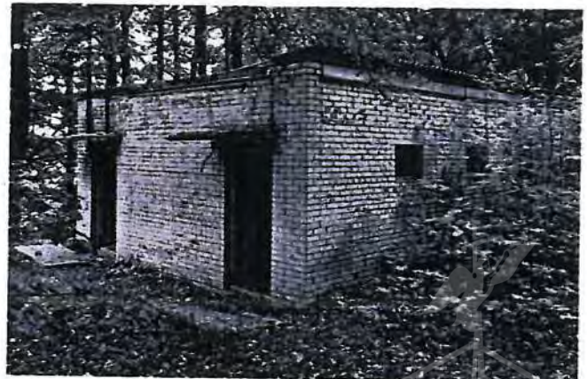
60. Фрагмент территории объекта культурного наследия (постройка хоз. назначения в северо-западной части (общественный туалет))
