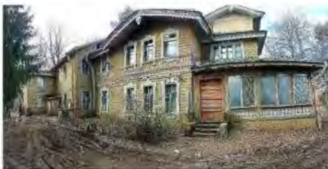
Фото 1. Восточный фасад ОКН (28.03.2025)
