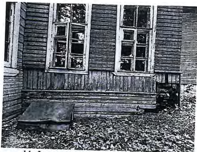
14. Фрагмент западного фасада объекта культурного наследия
