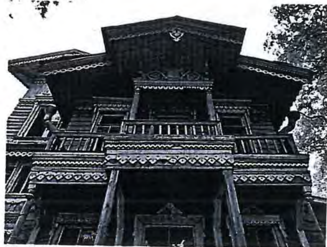
26. Трехчастный балкон западного фасада объекта культурного наследия
