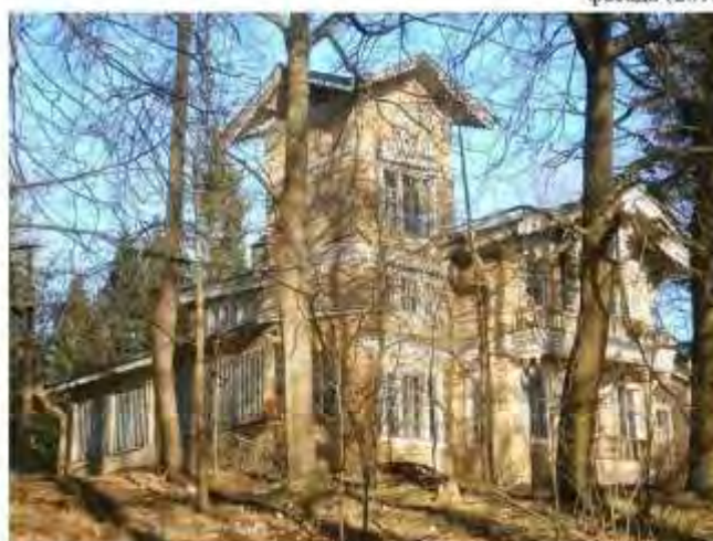
Фото 17. Вид на части северного и западного фасадов (май 2017 г.)
