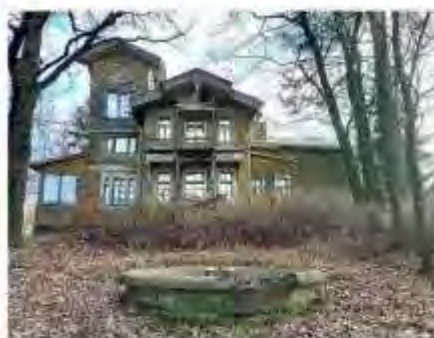
Фото 2. Западный фасад ОКН (28.03.2025)
