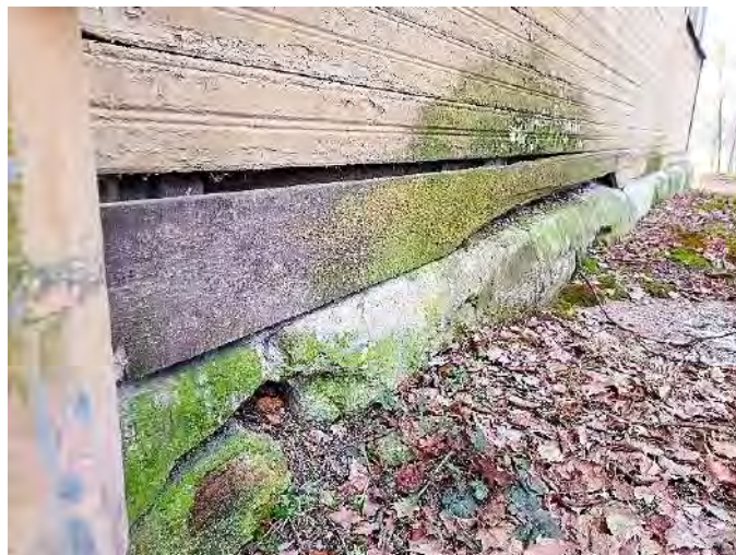
Фото 34. Вид на цоколь северного фасада
