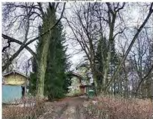
Фото 22. Вид на восточный фасад
