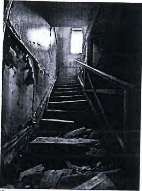
55. Интерьеры. Лестница южной части здания
