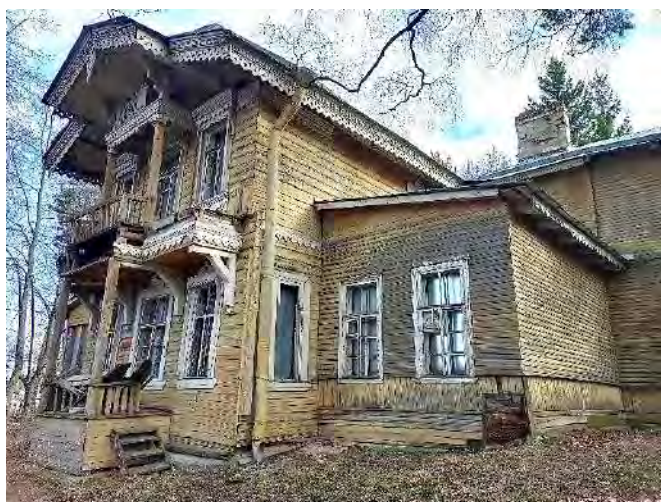
Фото 40. Вид на центральную часть западного фасада
