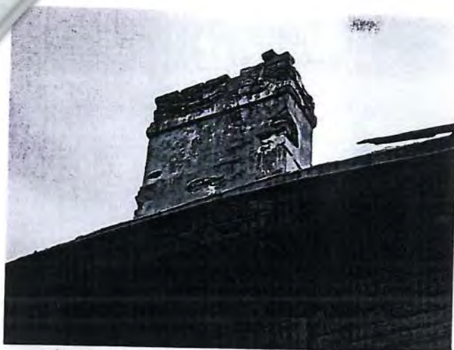
31. Состояние кирпичной печной трубы
