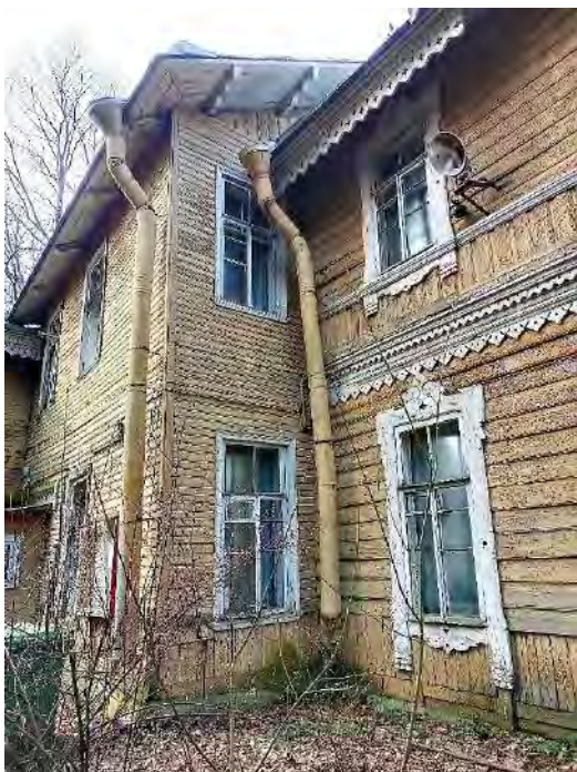
Фото 28. Вид на центральную часть восточного фасада
