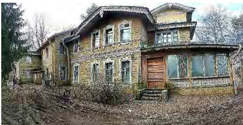
Фото 1. Восточный фасад ОКН (28.03.2025)
