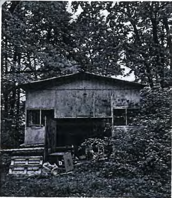
61. Фрагмент территории объекта культурного наследия (постройка хоз. назначения в северо-восточной части)
