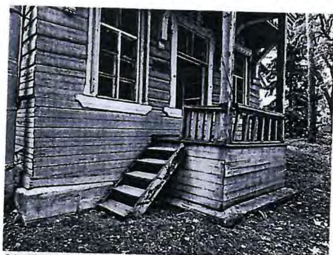
21. Деревянное крыльцо западного фасада объекта культурного наследия
