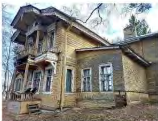
Фото 40. Вид на центральную часть западного фасада
