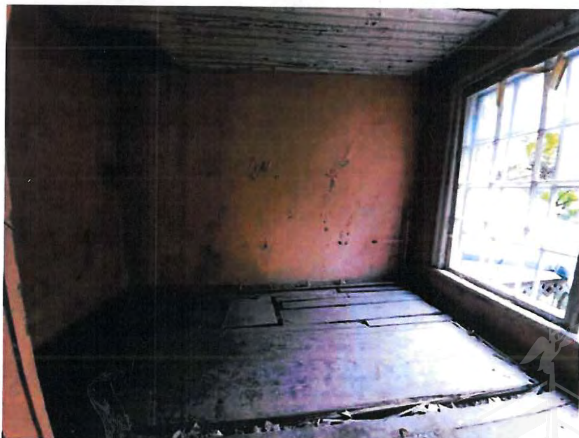
7. Интерьеры объекта культурного наследия, мансарда
