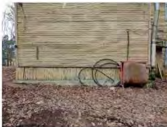
Фото 24. Вид на цоколь левой части восточного фасада
