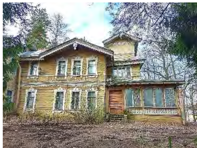
Фото 31. Вид на правую часть восточного фасада и вход в ч.п.1 (тамбур) пом.1-Н
