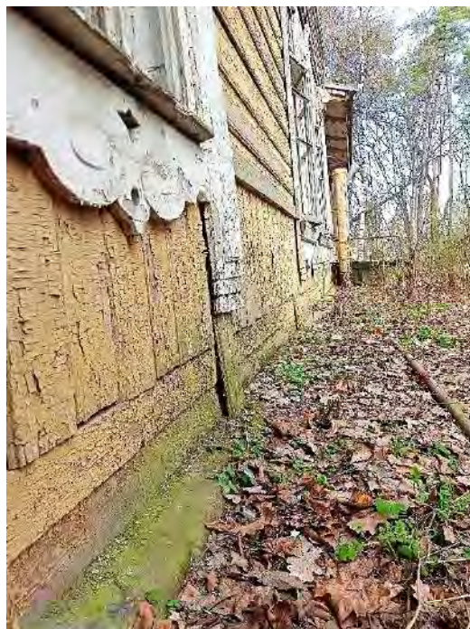
Фото 29. Вид на цоколь центральной части Восточного фасада
