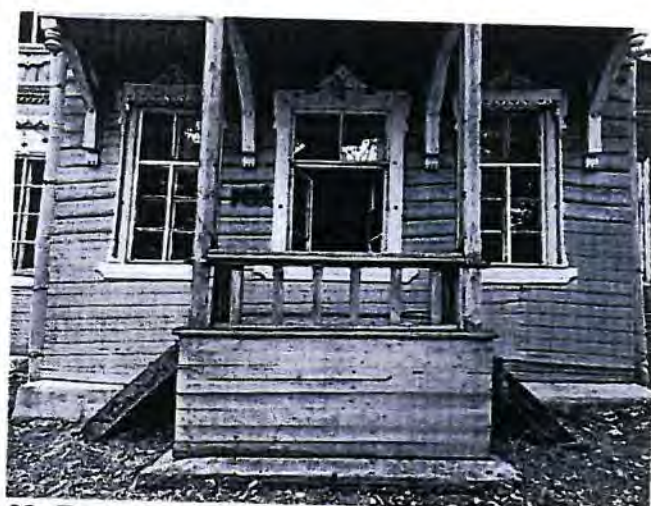
22. Деревянное крыльцо западного фасада объекта культурного наследия
