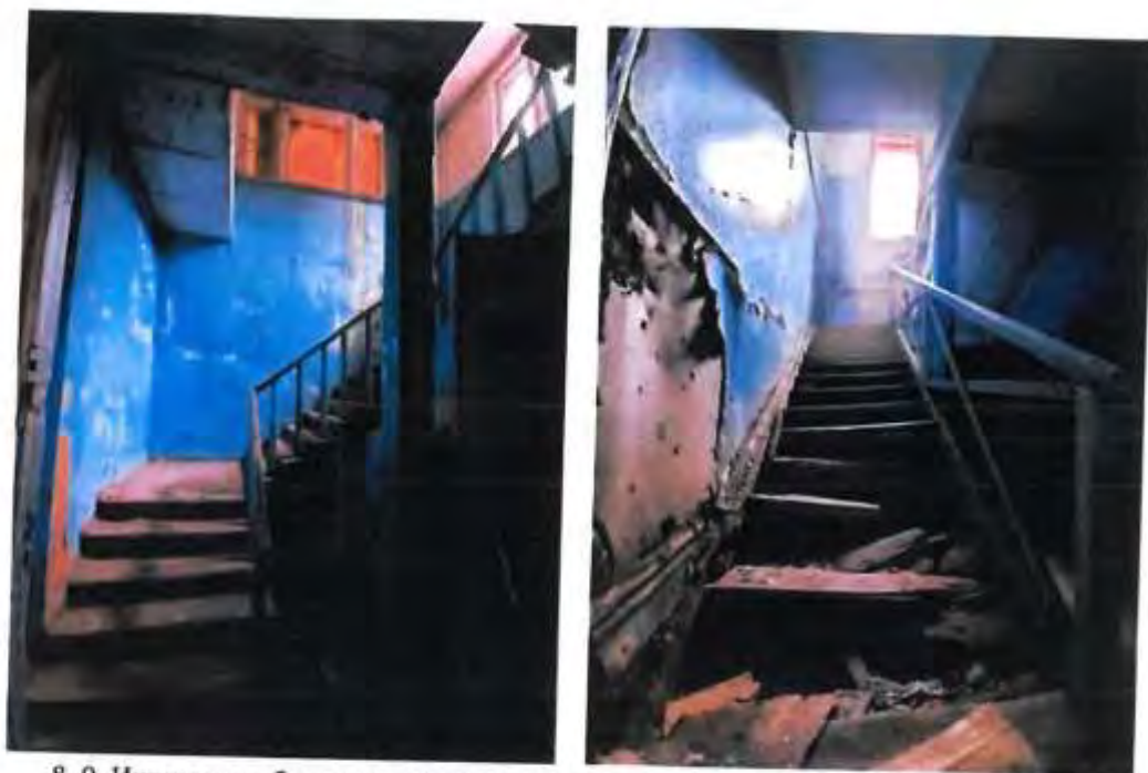
8-9. Интерьеры объекта культурного наследия, лестницы северной и южной частей
