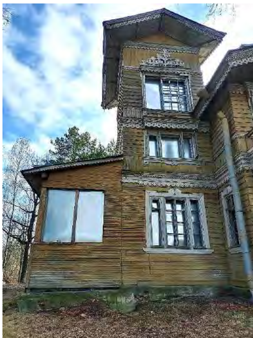
Фото 37. Вид на левую часть западного фасада
