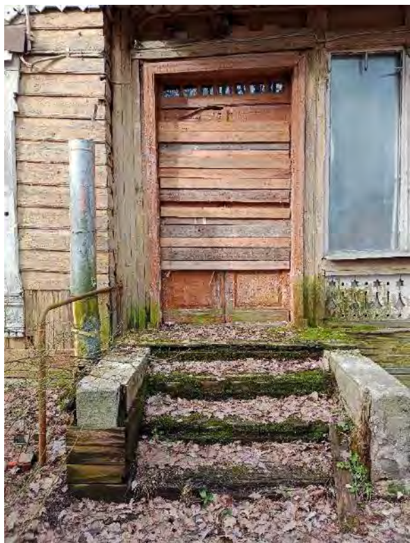
Фото 35. Вид на правую часть восточного фасада и вход в ч.п.1 (тамбур) пом.1-Н
