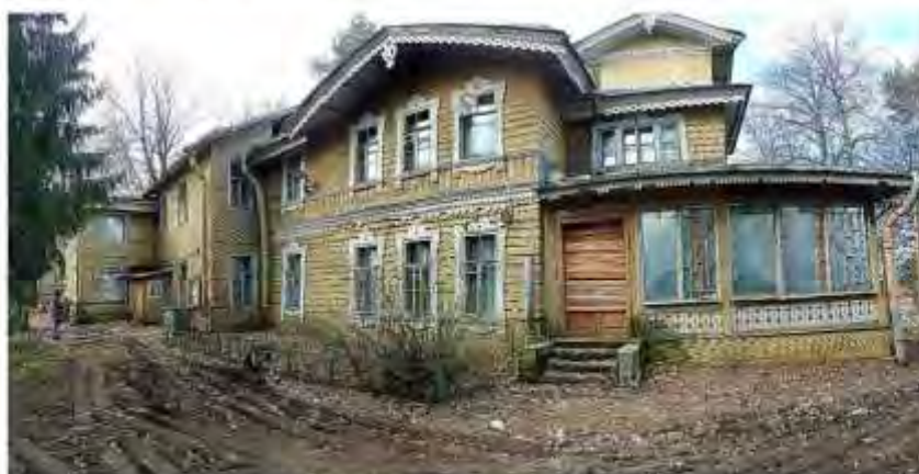
Фото 32. Панорамный вид на восточный фасад
