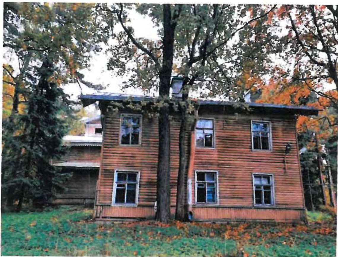
4. Вид на южный фасад объекта культурного наследия
