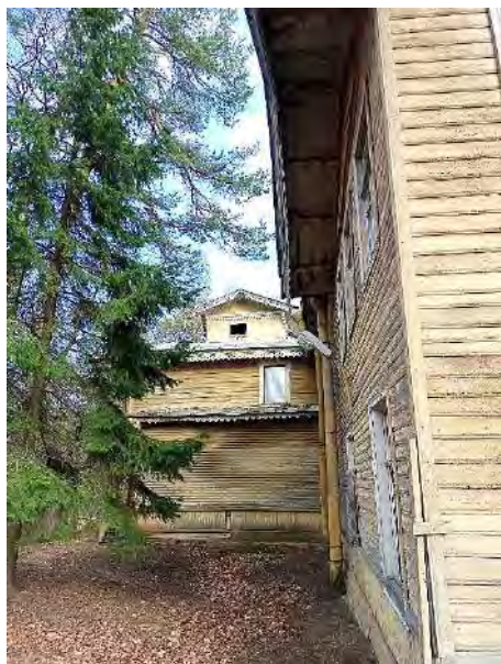
Фото 41. Вид с юго-западного угла ОКН
