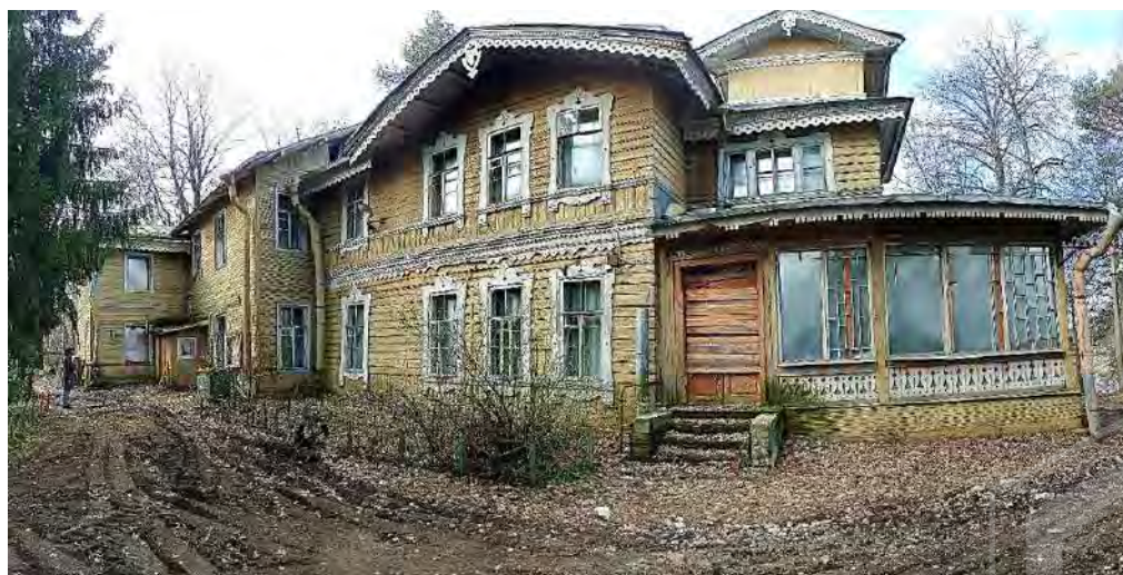
Фото 32. Панорамный вид на восточный фасад
