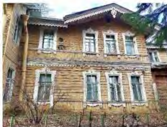
Фото 27. Вид на центральную часть восточного фасада
