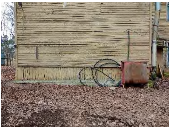
Фото 24. Вид на цоколь левой части восточного фасада
