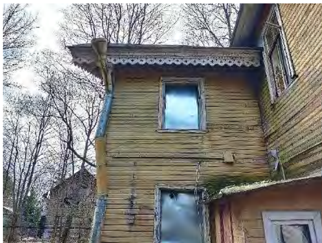
Фото 26. Вид на часть восточного фасада возле входа в ч.п.19 (тамбур) пом.1-Н
