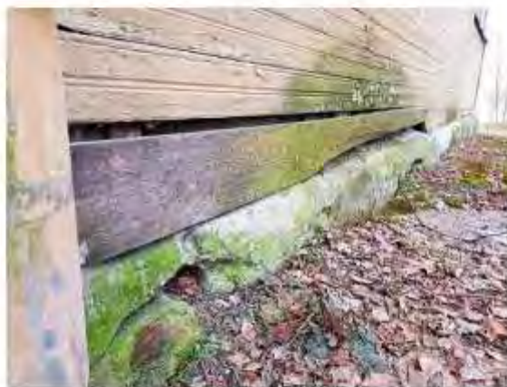
Фото 34. Вид на цоколь северного фасада
