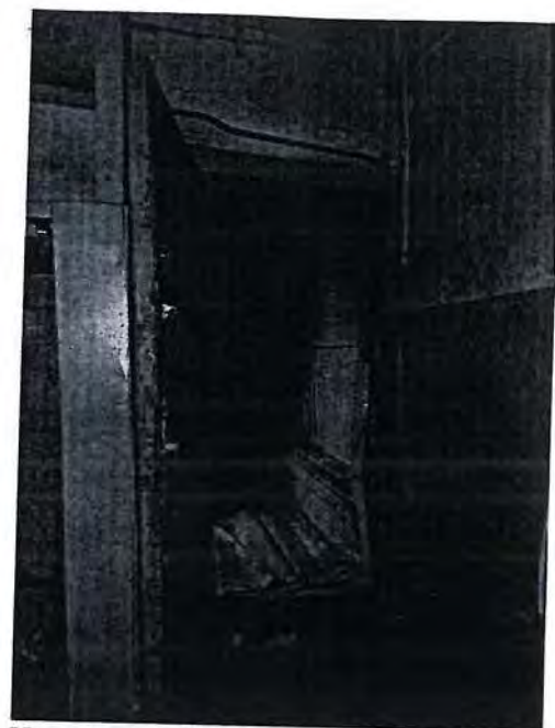
44. Интерьеры. Деформация дверного проема
