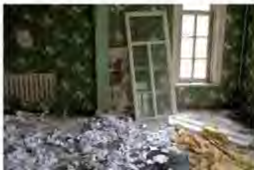
Фото 18. Одно из помещений ОКН (июль 2020 г.)
