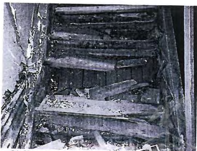
54. Интерьеры. Лестница южной части здания
