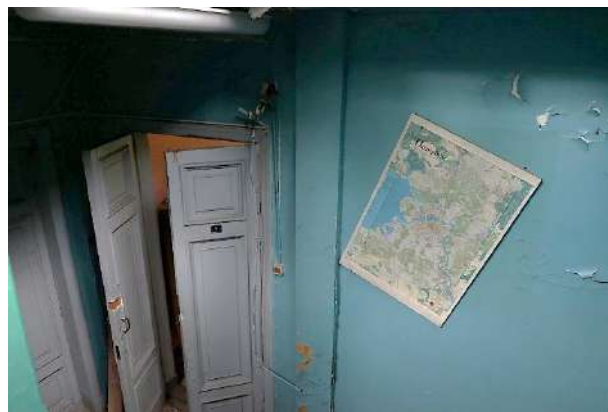
Фото 19. Одно из помещений ОКН (июль 2020 г.)
