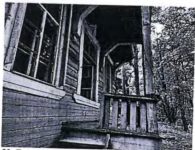
23. Деревянное крыльцо западного фасада объекта культурного наследия
