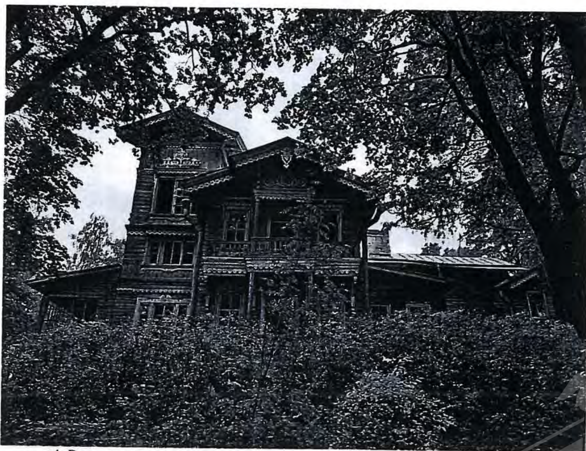
4. Вид на северную часть западного фасада объекта культурного наследия
