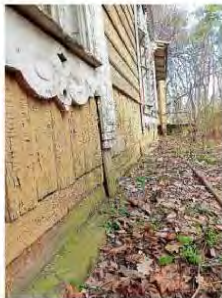
Фото 29. Вид на цоколь центральной части Восточного фасада
