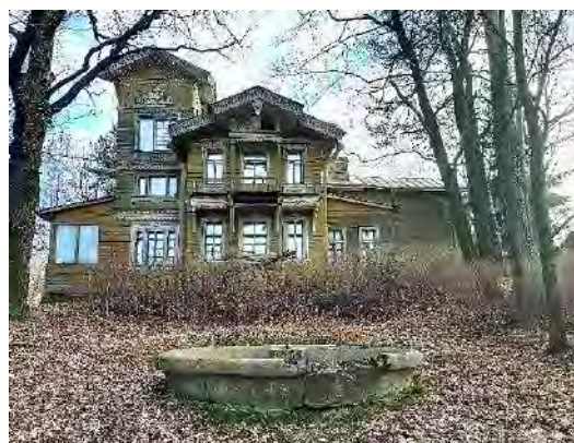
Фото 2. Западный фасад ОКН (28.03.2025)
