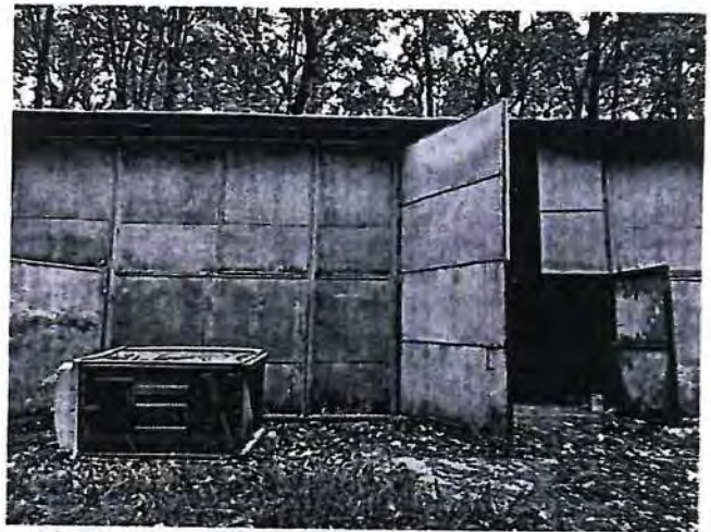
58. Фрагмент территории объекта культурного наследия (постройка хоз. назначения в юго-восточной части)
