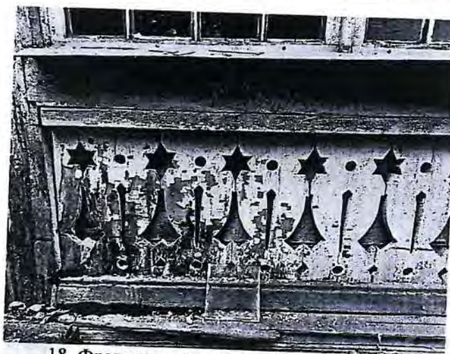
18. Фрагмент восточного фасада объекта культурного наследия
