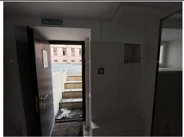
Фото № 22 – Внутреннее состояние помещения
