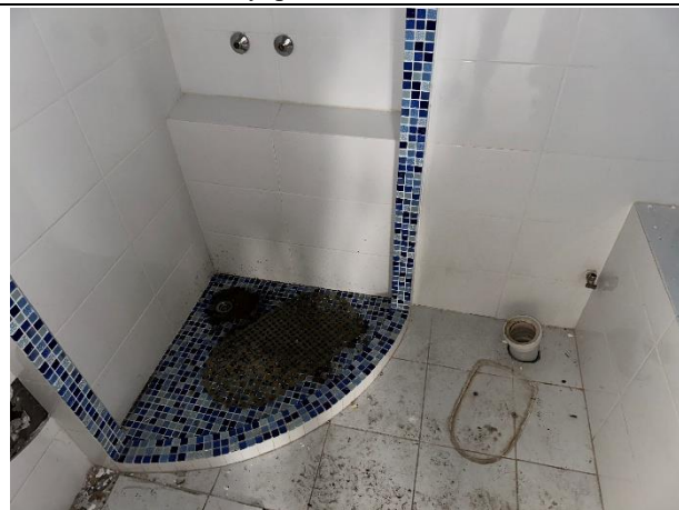
Фото № 16 – Внутреннее состояние помещения
