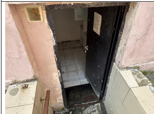
Фото № 9 – Внутреннее состояние помещения
