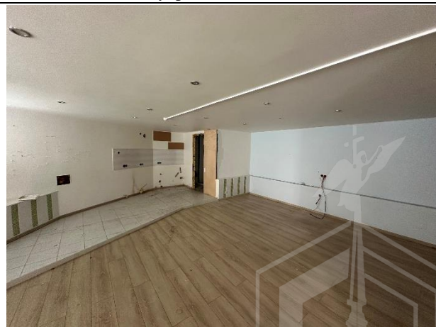
Фото № 12 – Внутреннее состояние помещения
