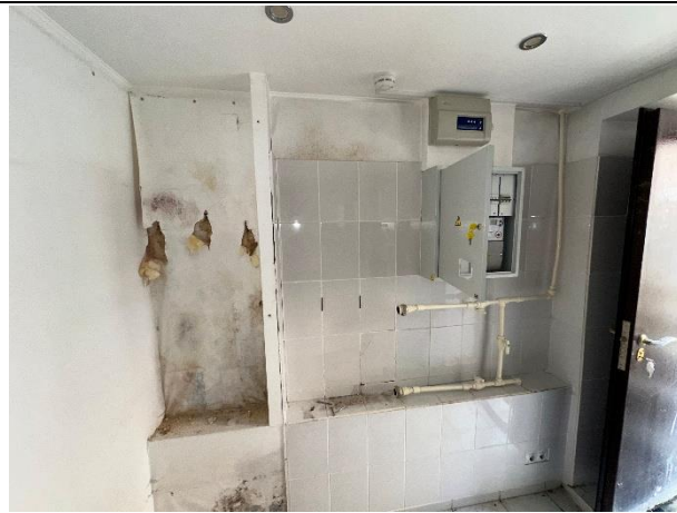
Фото № 21 – Внутреннее состояние помещения
