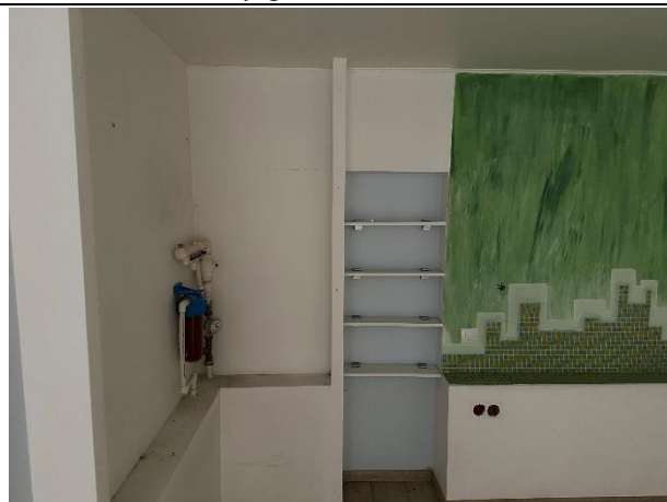
Фото № 15 – Внутреннее состояние помещения
