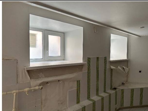
Фото № 13 – Внутреннее состояние помещения
