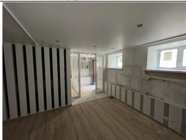
Фото № 19 – Внутреннее состояние помещения
