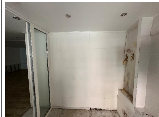
Фото № 11 – Внутреннее состояние помещения
