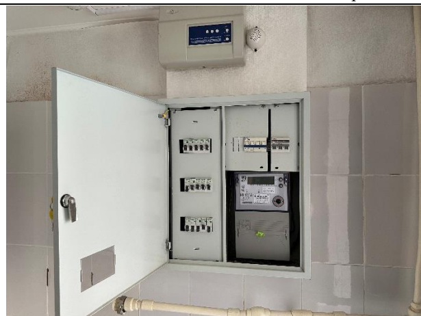
Фото № 10 – Внутреннее состояние помещения
