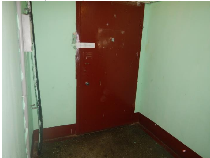
Фото №9 (вход в помещение)
