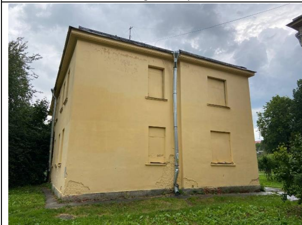
Фото № 5. Внешний вид здания
