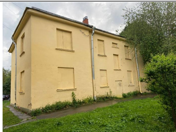
Фото № 6. Внешний вид здания
