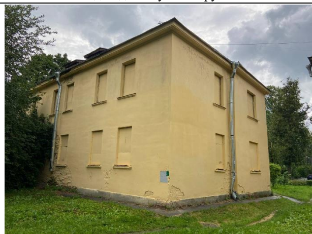
Фото № 4. Внешний вид здания
