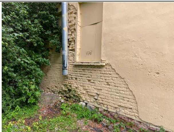
Фото № 7. Внешний вид здания
