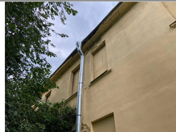
Фото № 10. Внешний вид здания
