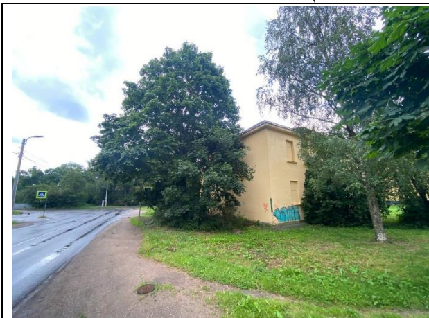
Фото № 1. Подъездные пути и окружение объекта
