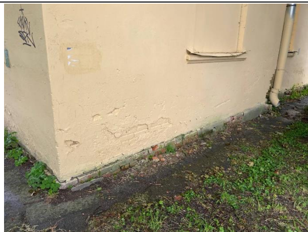
Фото № 8. Внешний вид здания
