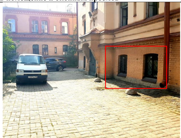
Фото 8. Вид окон Объекта оценки
