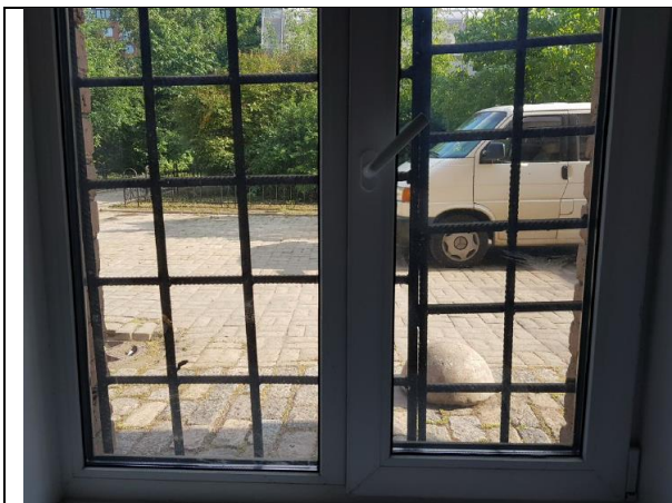
Фото 15. Внутреннее состояние Объекта оценки
