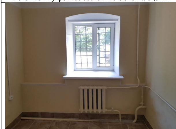
Фото 13. Внутреннее состояние Объекта оценки
