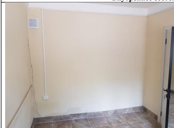
Фото 11. Внутреннее состояние Объекта оценки
