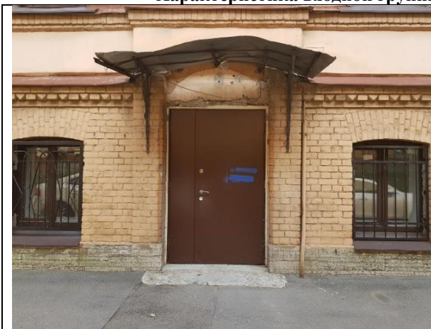
Фото 7. Общий вход с улицы (с торца)
