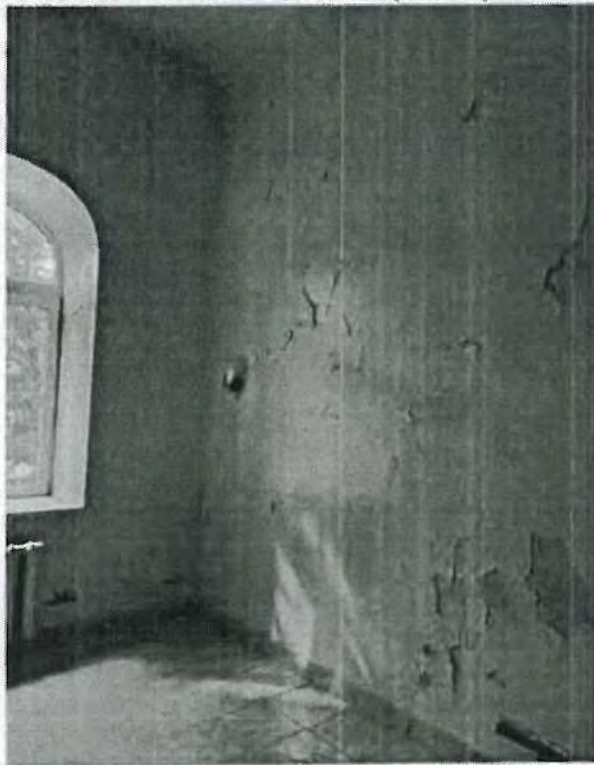
3.23. Помещение 1-Н, ч.п. 58 (2 этаж).
