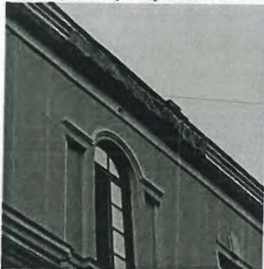
1.15, 1.16. Фрагменты северного фасада, утрата элемента слива, биопоражения. Крыльцо.
