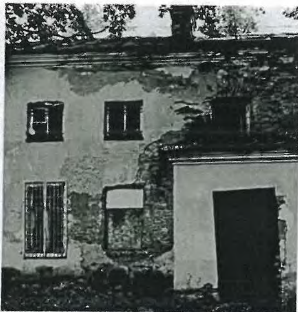
7.6. Фрагмент южного фасада.
