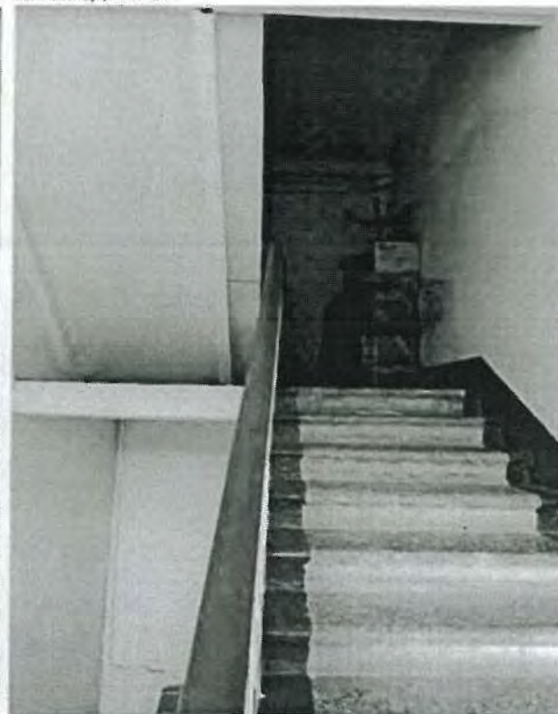
6.22. Двухмаршевая лестница в южной части здания.
