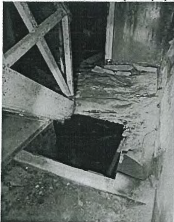
7.15. Помещение 1-Н, ч.п. 1. Утрата перекрытия. 7.16. Одномаршевая лестница.
