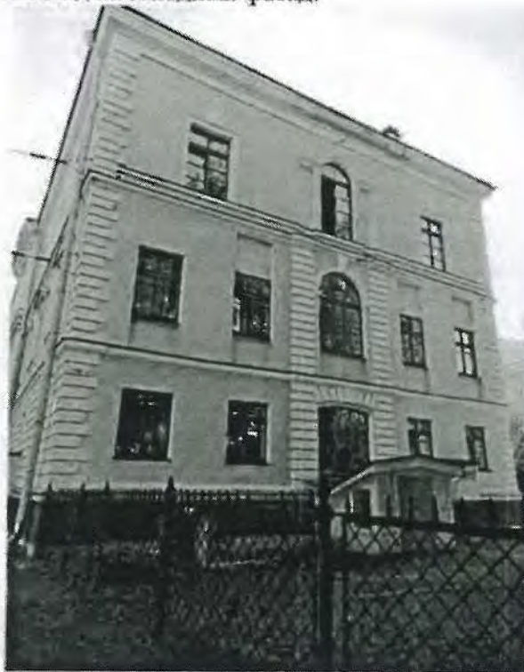
1.5. Вид на западный фасад.
