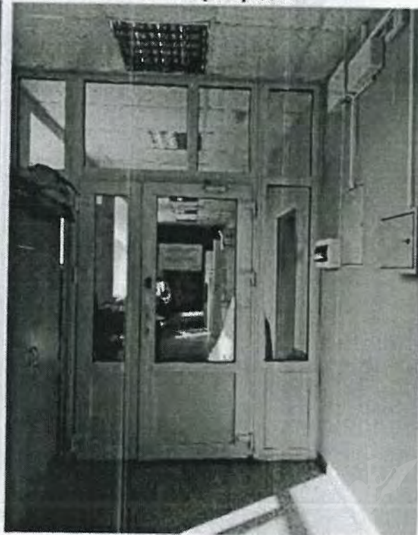
6.20. Помещение 1-Н, ч.п. 9 (3 этаж). Устройство новой перегородки.
