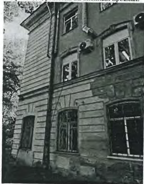
6.7. Фрагмент западного фасада. Кондиционеры, воздуховоды, решетки на оконных проемах. 6.8. Вид на северный фасад.
