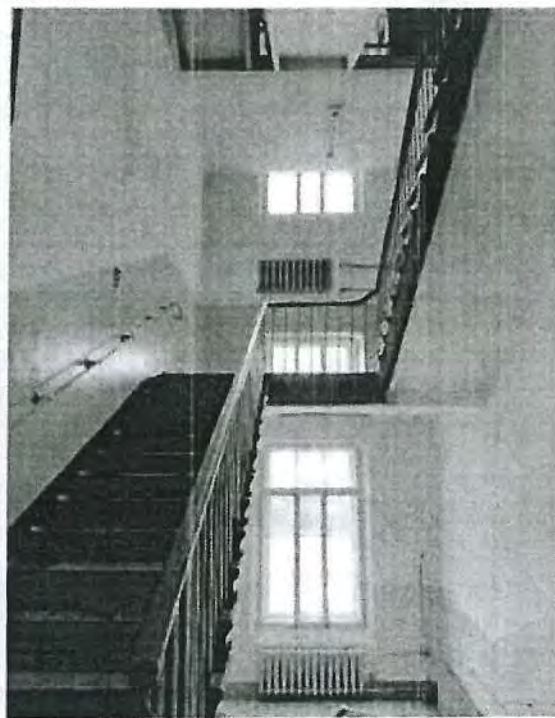
29. Двухмаршевая лестница в восточной части здания.
