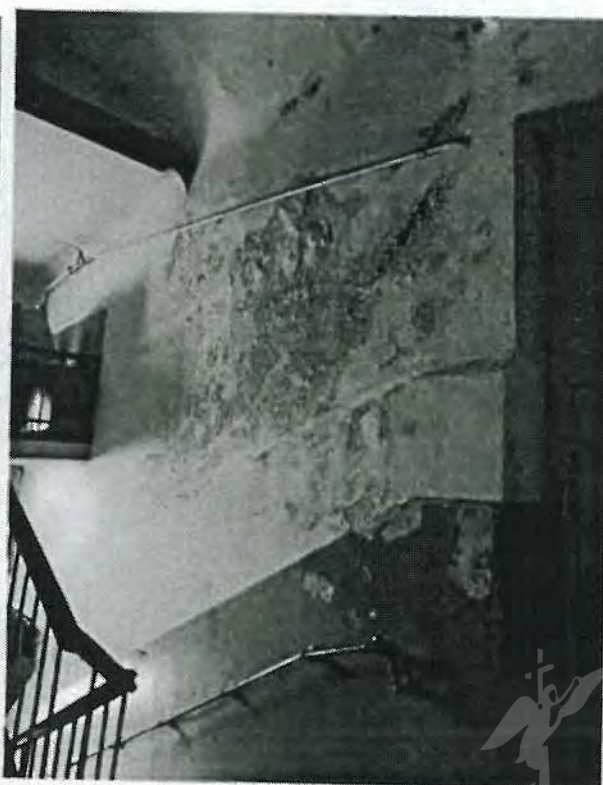
3.26, 3.27. Двухмаршевая лестница в восточной части здания. Следы намокания, вспучивание и шелушение отделочных слоев.
