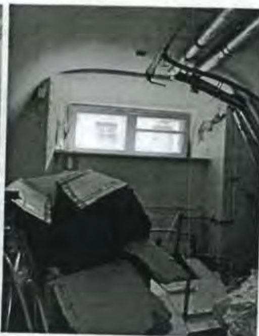
1.19, 1.20. Коридор в уровне подвального помещения. Следы намокания, шелушение окрасочного слоя.
