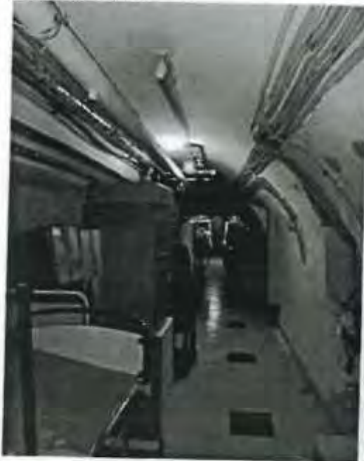
1.19, 1.20. Коридор в уровне подвального помещения. Следы намокания, шелушение окрасочного слоя.
