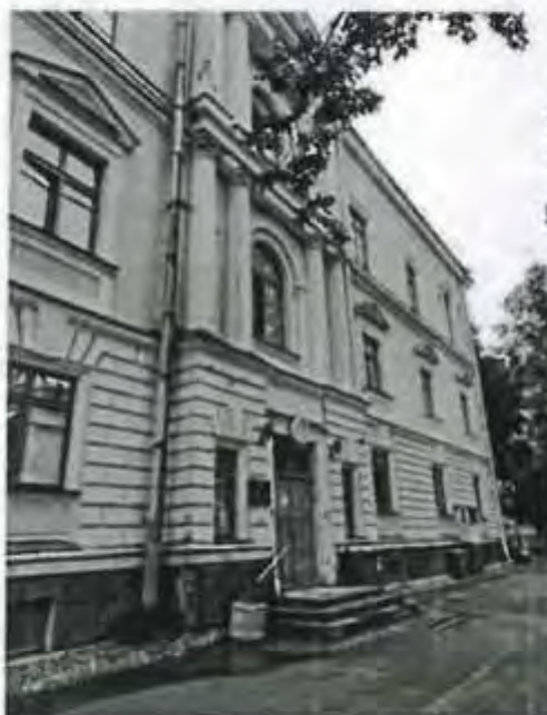
1.7. Центральная часть северного фасада.
