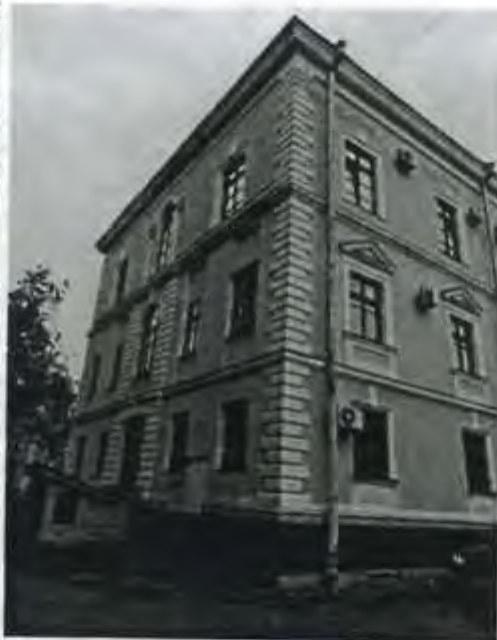
1.10. Вид на западный и часть южного фасадов. Кондиционеры.
