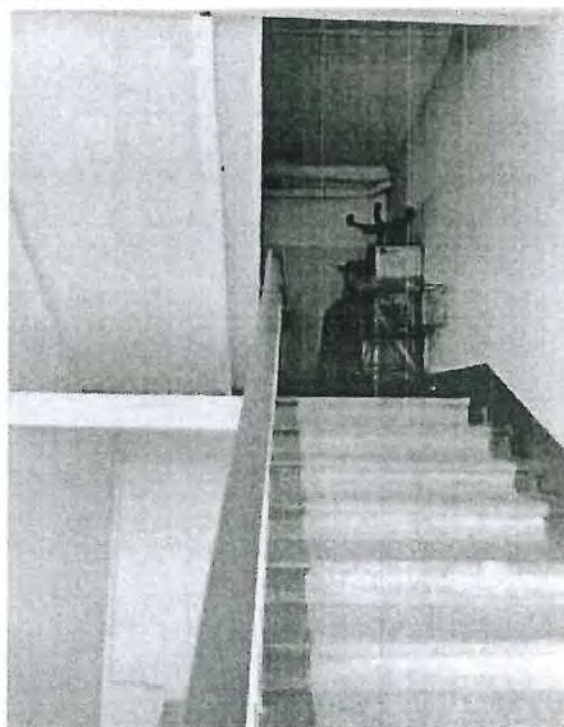
47. Двухмаршевая лестница в южной части здания.
