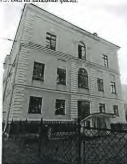
1.5. Вид на западный фасад.
