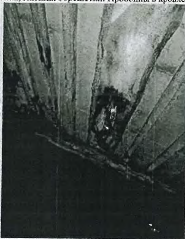
6.25, 6.26. Конструкции крыши. Следы намокания, гниения обрешетки. Пробойны в кровле.
