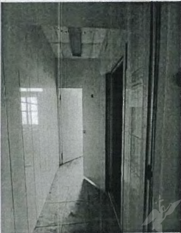
3.23. Помещение 1-Н, ч.п. 67 (2 этаж).
