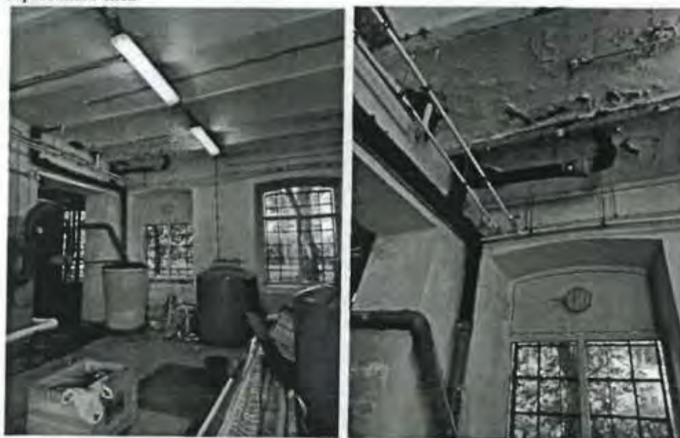
6.15, 6.16. Помещение 3-Н, ч.п. 1 (1 этаж). Коррозия балок, следы намокания, шелушение окрасочного слоя
