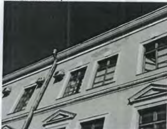
1.15, 1.16. Фрагменты северного фасада, утрата элемента слива, биопоражения. Крыльцо.
