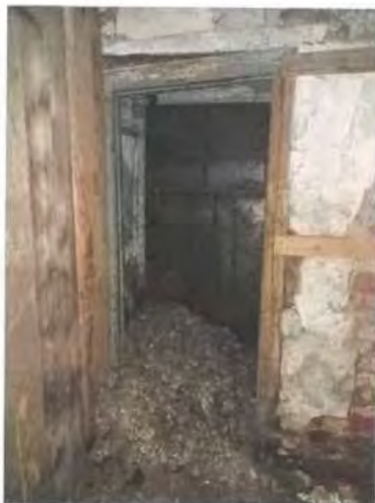
Фото 21. Ч.п.9 (конюшня) пом.1-Н (выход ч/з восточный фасад)
