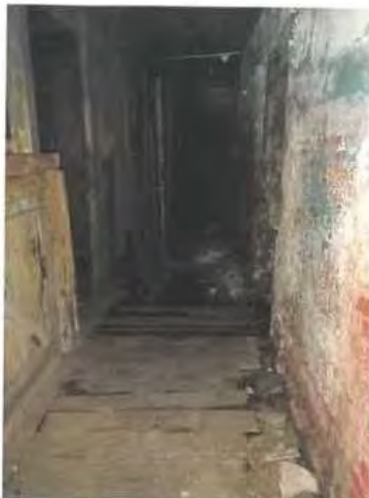
Фото 17. Ч.п.7 (конюшня) пом.1-Н
