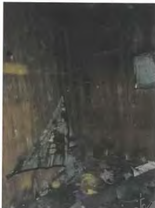
Фото 24. Ч.п.5 (хоз.помещение) пом.1-Н
