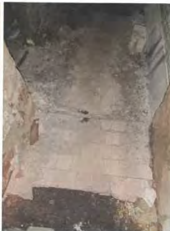
Фото 20. Ч.п.4 пом.1-Н (полы коридора)
