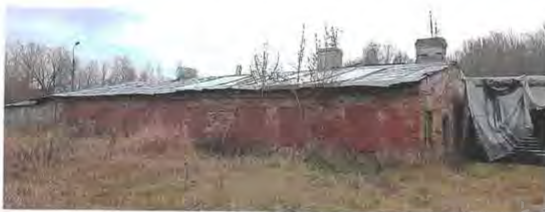
Фото 4. Фасады: северный и часть западного
