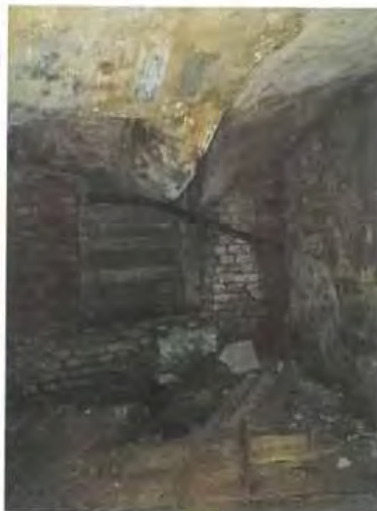
Фото 22. Ч.п.9 (конюшня) пом.1-Н
