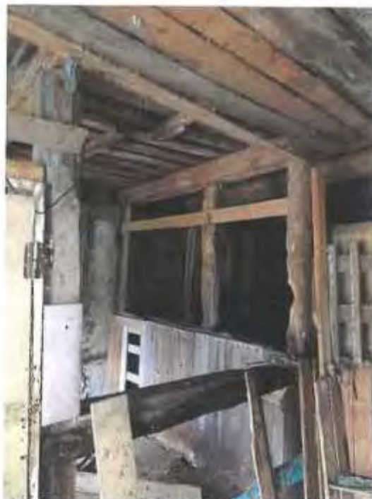
Фото 13. Ч.п.6 (конюшня) пом.1-Н
