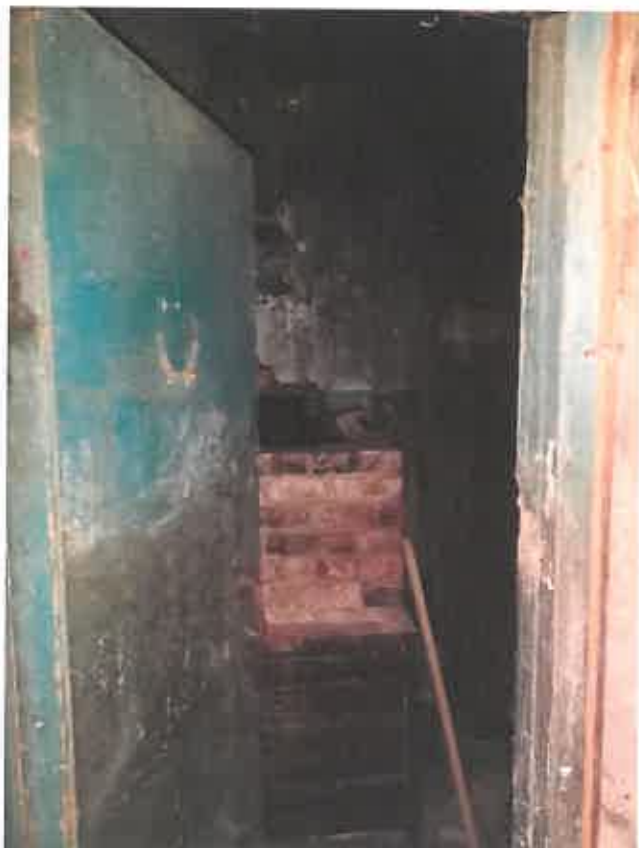
Фото 23. Вход в ч.п.5 (хоз.помещение) пом.1-Н
