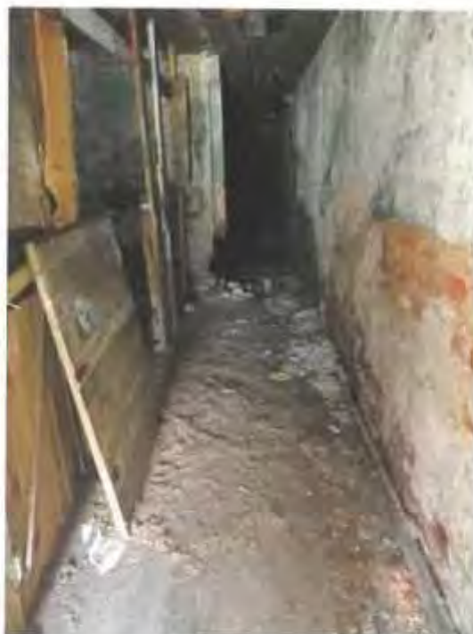
Фото 15. Ч.п.6 (конюшня) пом.1-Н
