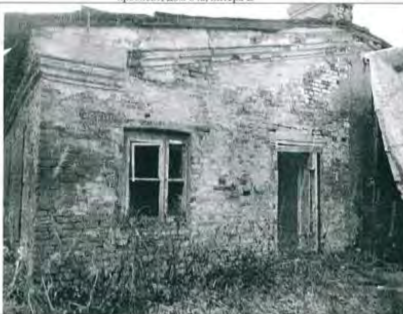
Описание: Вид на Объект
