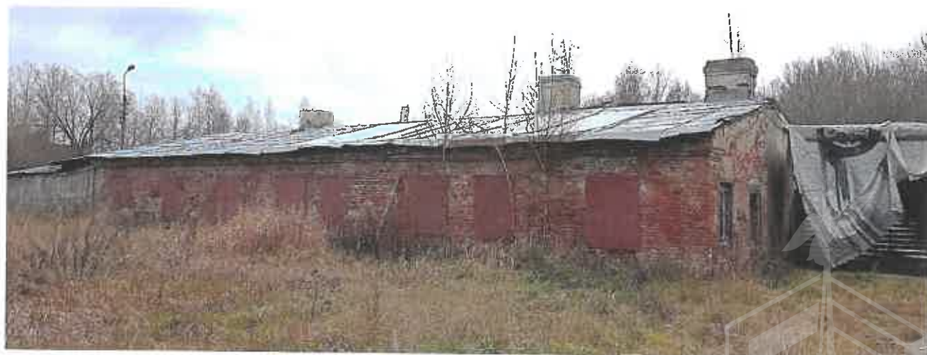
Фото 4. Фасады: северный и часть западного
