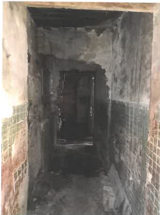
Фото 19. Ч.п.4 пом.1-Н (коридор)
