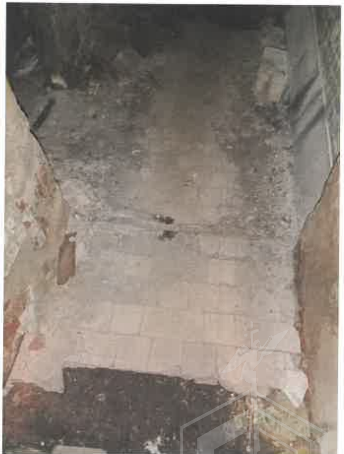
Фото 20. Ч.п.4 пом.1-Н (полы коридора)
