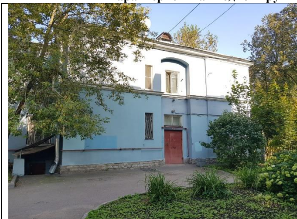
Фото 5. Общий вход с улицы (с торца)
