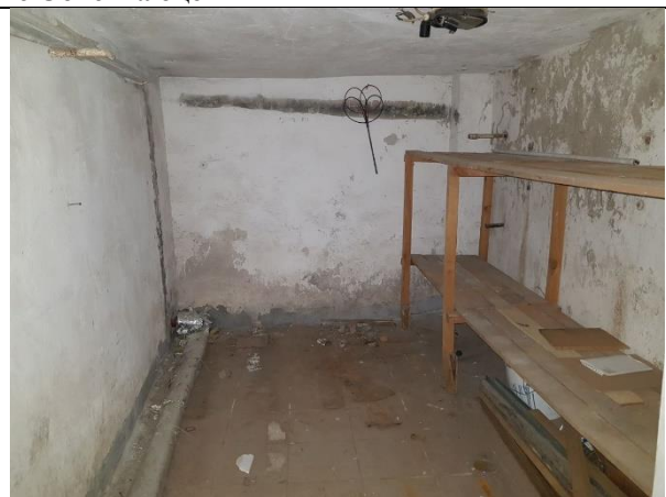
Фото 10. Внутреннее состояние Объекта оценки
