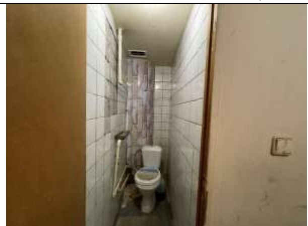
Фото 34. Типичное состояние Объекта оценки
