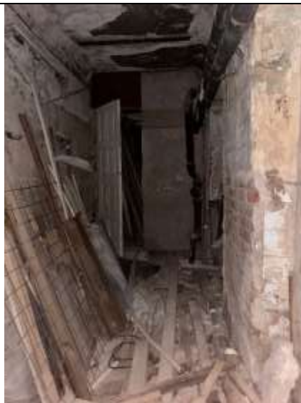
Фото 30. Типичное состояние Объекта оценки
