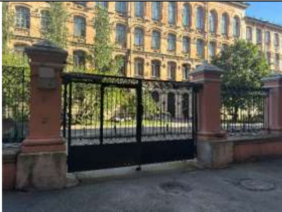
Фото 23. Входная группа в здание расположения Объекта оценки
