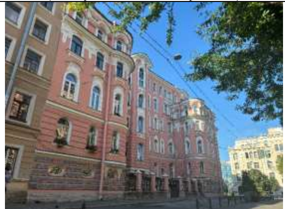
Фото 20. Вид здания расположения Объекта оценки
