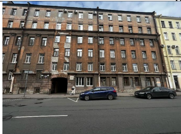
Фото 1. Вид здания, в котором расположен Объект оценки
