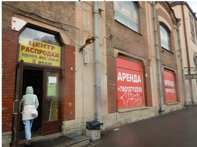
Фото №4 (вход в помещение)
