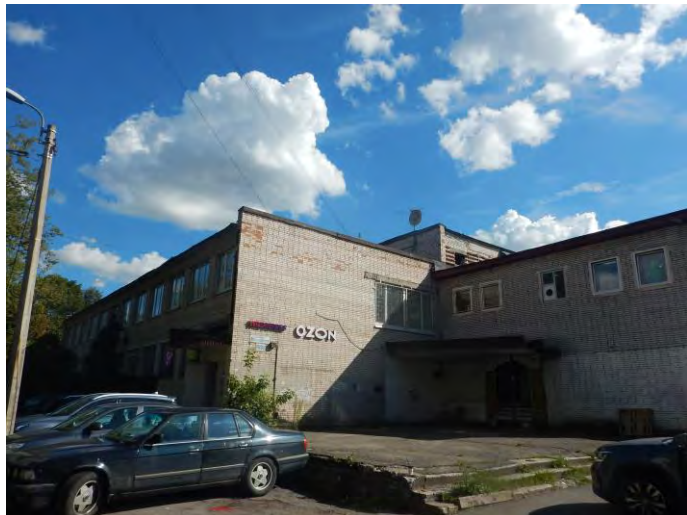
Фото №3 (вход в помещение)
