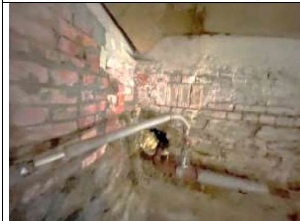
Фото 37. Типичное состояние Объекта оценки
