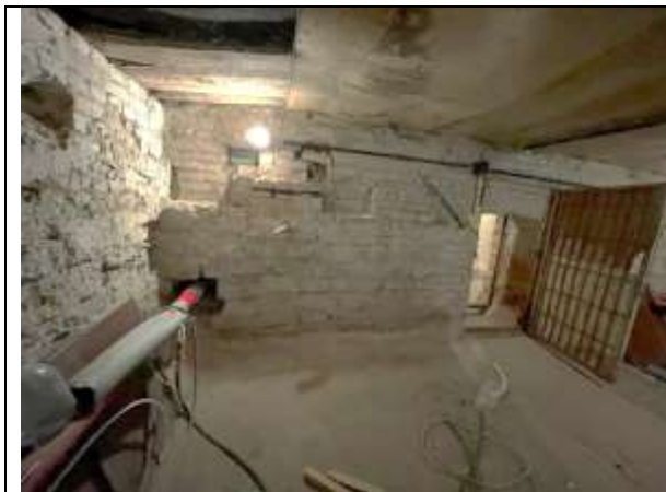
Фото 35. Типичное состояние Объекта оценки
