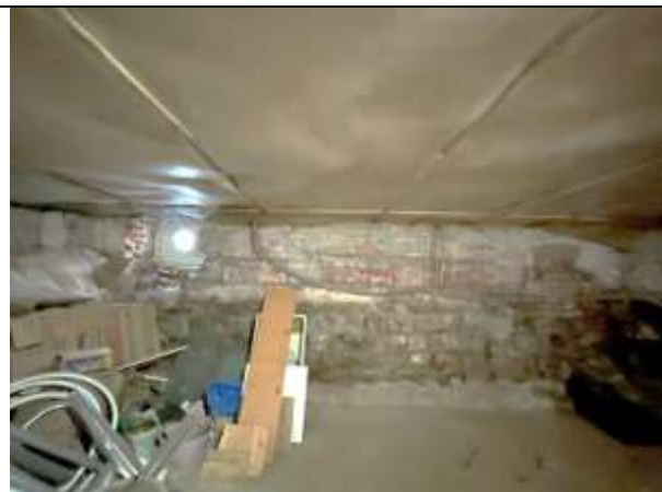
Фото 36. Типичное состояние Объекта оценки
