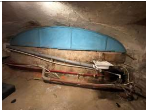
Фото 29. Типичное состояние Объекта оценки
