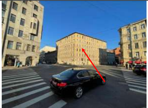
Фото 8. Вид здания расположения Объекта оценки
