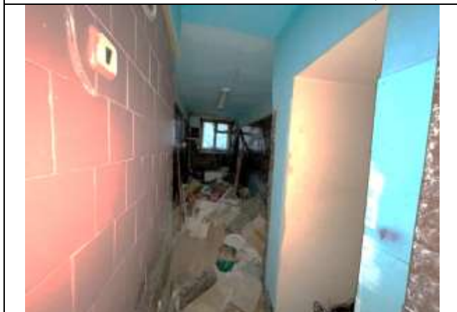
Фото 27. Типичное состояние Объекта оценки
