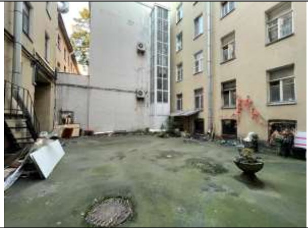
Фото 38. Проход через арку к Объекту оценки (Греческий проспект), внутридворовая территория Объекта оценки
