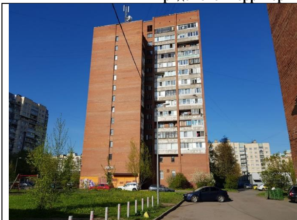
Фото 1. Вид здания, в котором расположен Объект оценки
