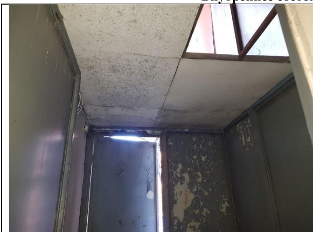
Фото 7. Внутреннее состояние Объекта оценки
