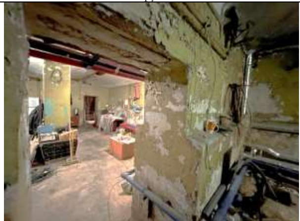
Фото 20. Типичное состояние Объекта оценки
