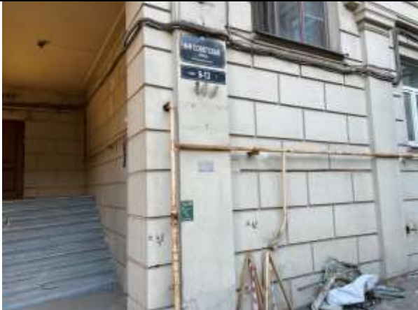
Фото 13. Адрес Объекта оценки
