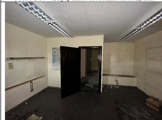
Фото № 19 – Внутреннее состояние помещения
