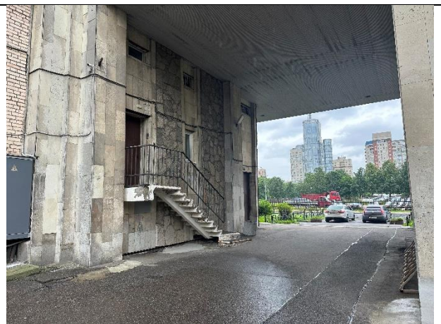
Фото № 8 – Общий вход из-под арки
