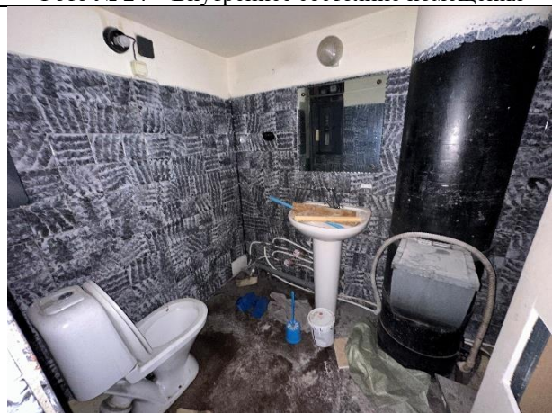
Фото № 26 – Внутреннее состояние помещения
