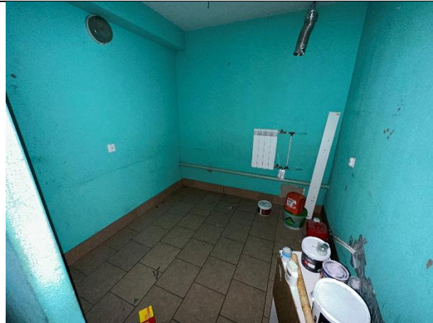
Фото № 31 – Внутреннее состояние помещения
