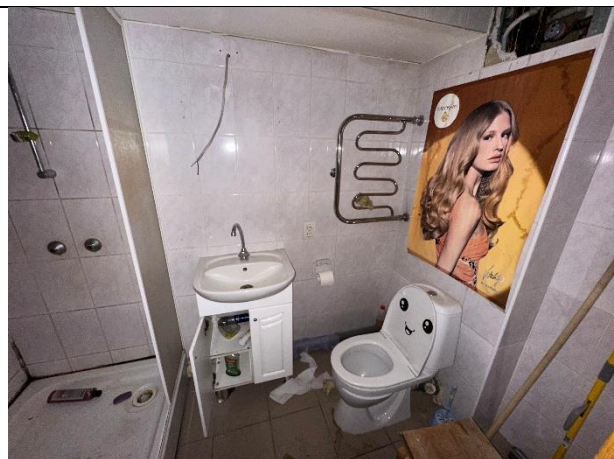
Фото № 24 – Внутреннее состояние помещения
