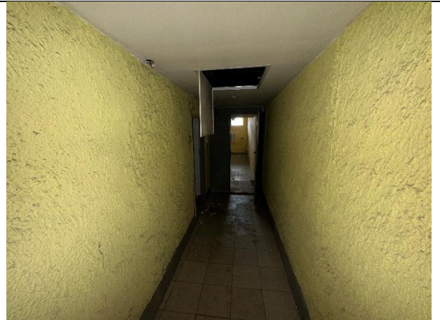
Фото № 32 – Внутреннее состояние помещения
