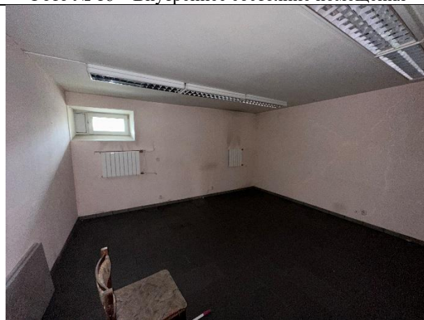
Фото № 20 – Внутреннее состояние помещения
