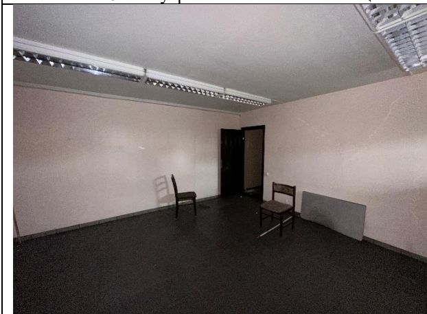
Фото № 21 – Внутреннее состояние помещения
