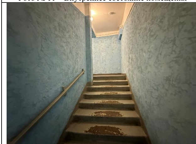
Фото № 13 – Внутреннее состояние помещения
