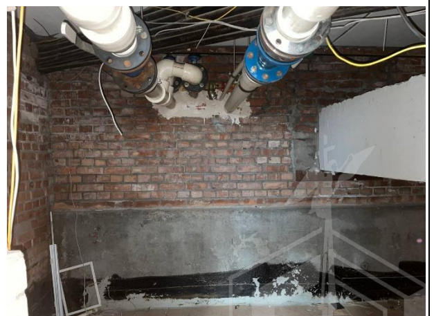
Фото № 28 – Внутреннее состояние помещения
