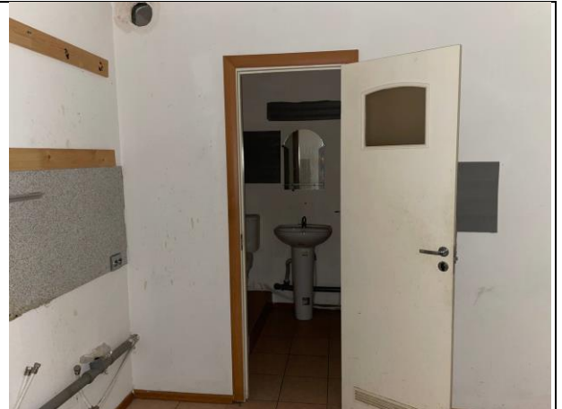
Фото № 22 – Внутреннее состояние помещения
