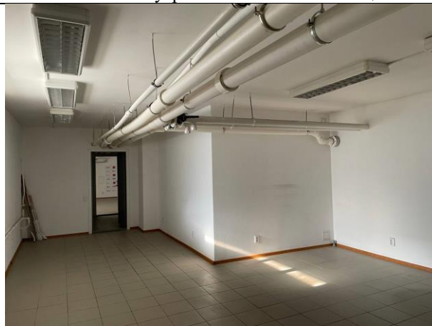
Фото № 16 – Внутреннее состояние помещения
