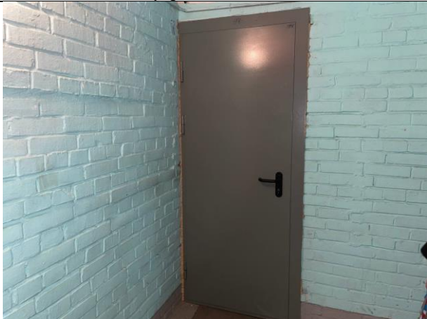
Фото № 31 – Вход в помещение
