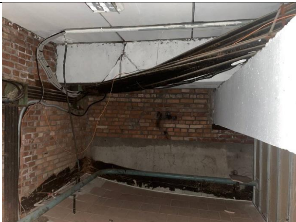
Фото № 29 – Внутреннее состояние помещения
