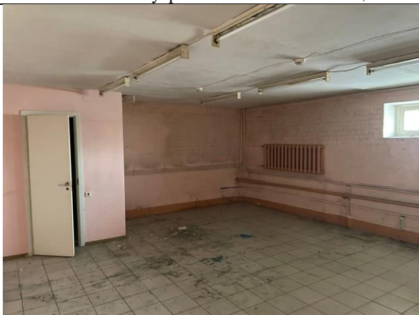
Фото № 17 – Внутреннее состояние помещения
