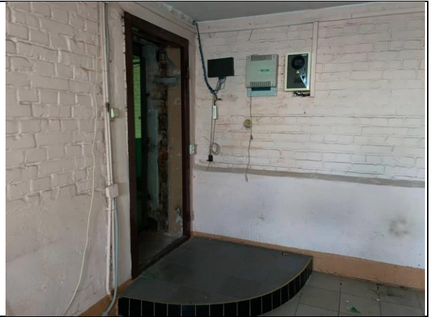
Фото № 12 – Внутреннее состояние помещения
