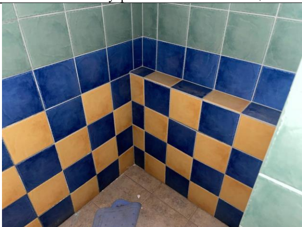
Фото № 25 – Внутреннее состояние помещения
