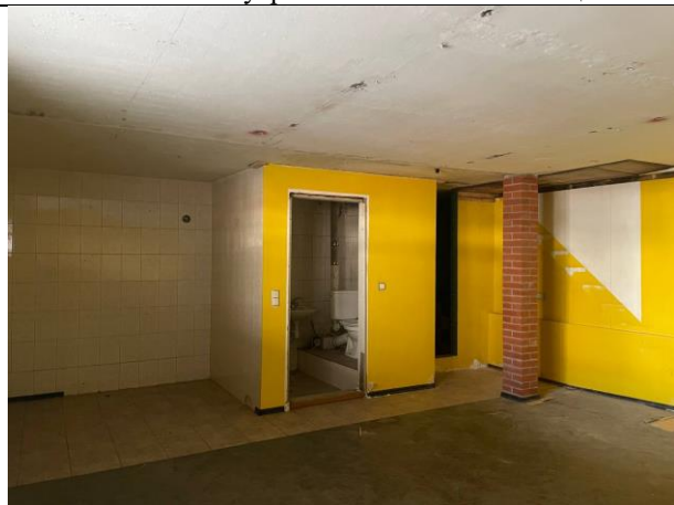
Фото № 22 – Внутреннее состояние помещения
