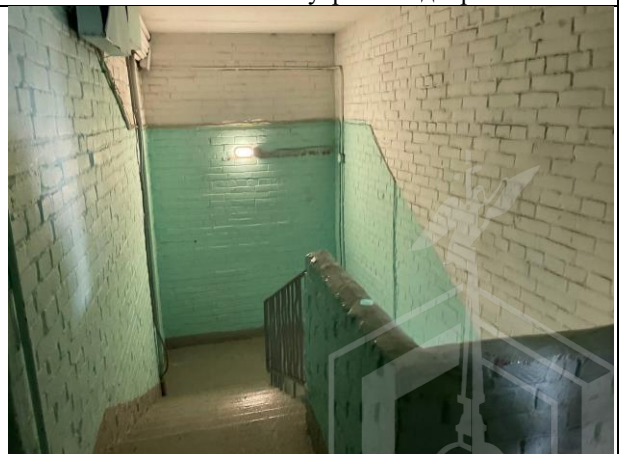
Фото № 10 – Лестничная клетка
