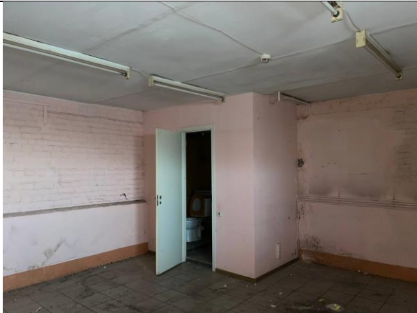
Фото № 13 – Внутреннее состояние помещения
