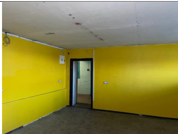
Фото № 20 – Внутреннее состояние помещения
