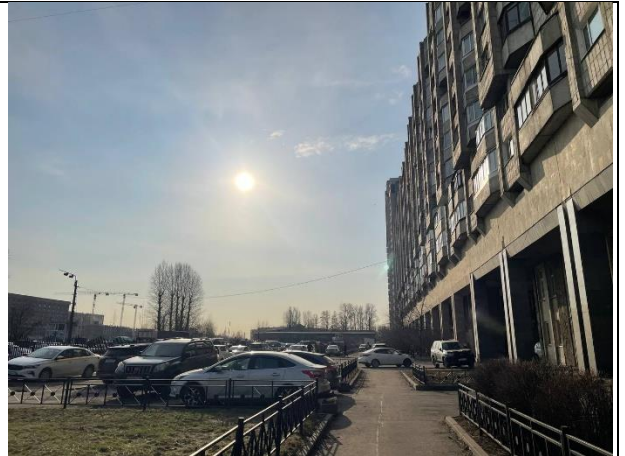
Фото № 4 – Ближайшее окружение и подъездные пути
