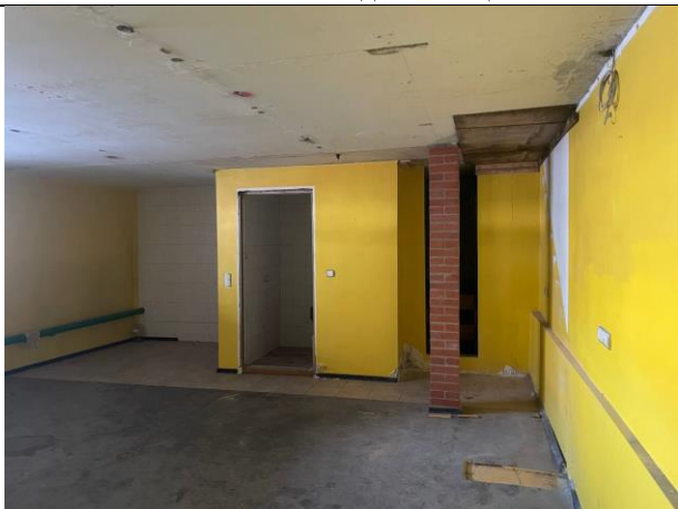
Фото № 21 – Внутреннее состояние помещения
