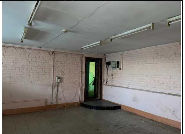
Фото № 14 – Внутреннее состояние помещения
