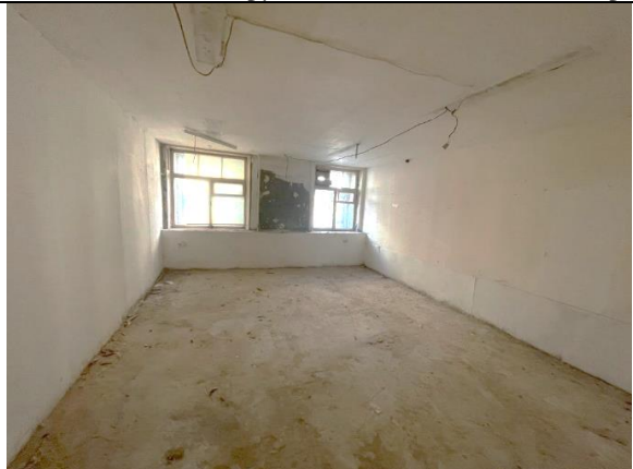
Фото 31. Типичное состояние Объекта оценки
