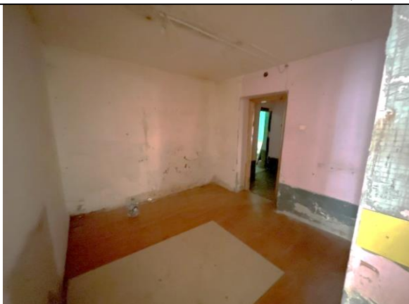
Фото 33. Типичное состояние Объекта оценки
