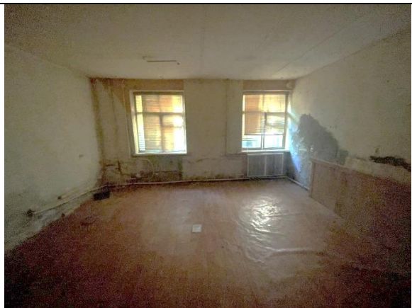
Фото 27. Типичное состояние Объекта оценки
