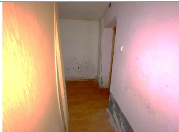
Фото 34. Типичное состояние Объекта оценки
