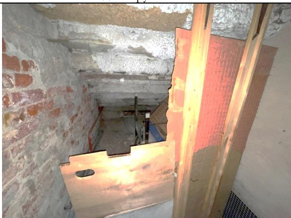
Фото 41. Типичное состояние Объекта оценки
