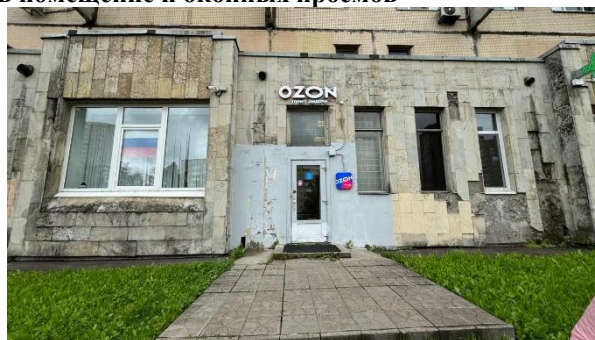
Фото 6. Общий вход с улицы
