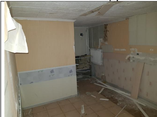
Фото 7. Внутреннее состояние Объекта оценки
