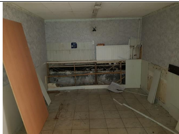
Фото 8. Внутреннее состояние Объекта оценки
