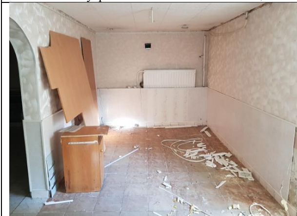
Фото 13. Внутреннее состояние Объекта оценки
