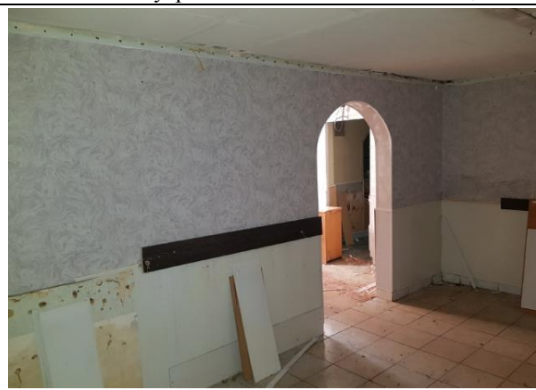
Фото 12. Внутреннее состояние Объекта оценки
