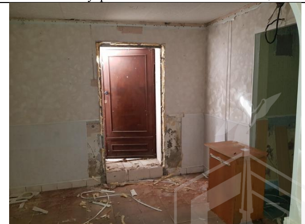
Фото 14. Внутреннее состояние Объекта оценки
