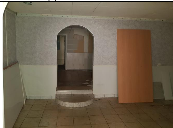
Фото 10. Внутреннее состояние Объекта оценки
