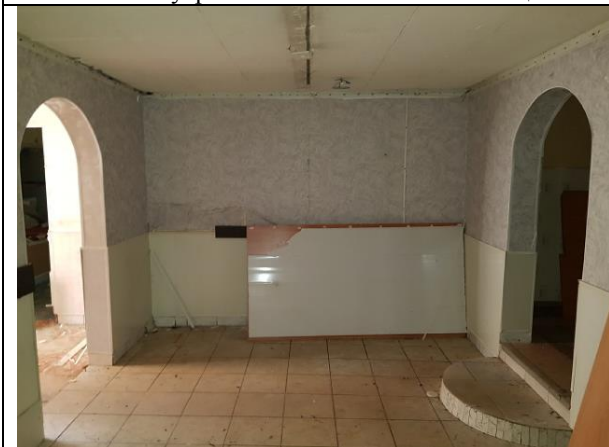
Фото 9. Внутреннее состояние Объекта оценки
