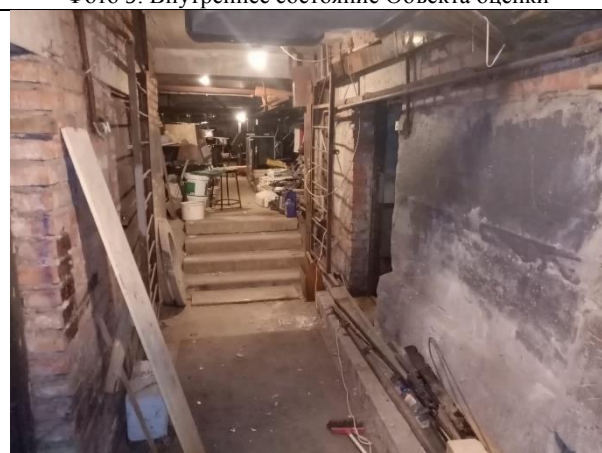
Фото 11. Внутреннее состояние Объекта оценки
