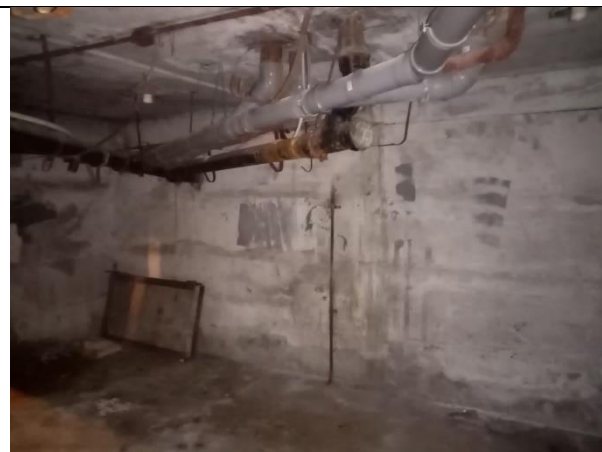
Фото 7. Внутреннее состояние Объекта оценки
