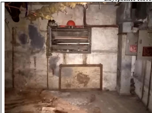
Фото 5. Внутреннее состояние Объекта оценки
