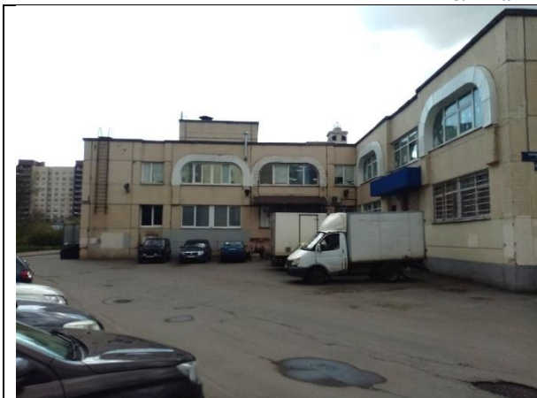
Фото 1. Вид здания, в котором расположен Объект оценки
