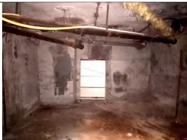
Фото 8. Внутреннее состояние Объекта оценки
