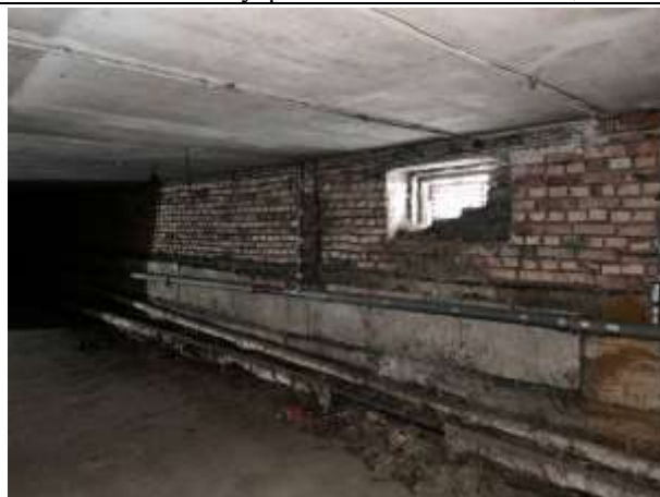
Фото № 15 – Внутреннее состояние помещения
