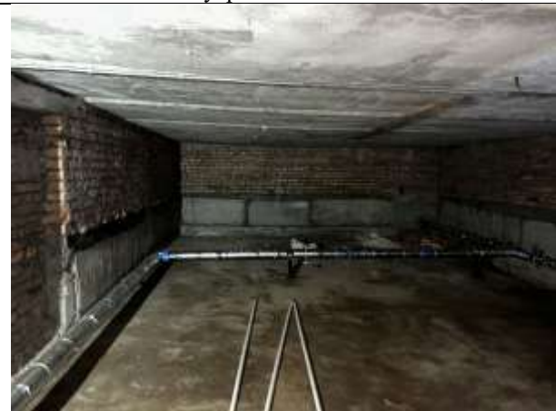
Фото № 12 – Внутреннее состояние помещения
