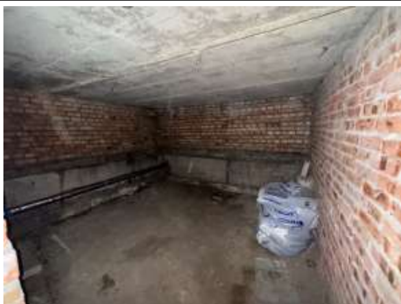
Фото № 13 – Внутреннее состояние помещения
