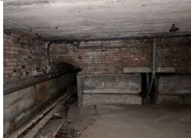
Фото № 14 – Внутреннее состояние помещения
