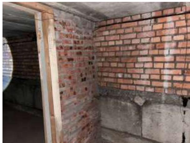
Фото № 18 – Внутреннее состояние помещения
