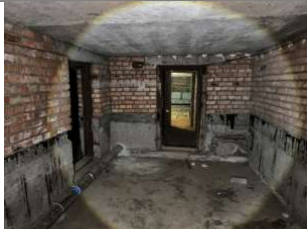
Фото № 10 – Внутреннее состояние помещения
