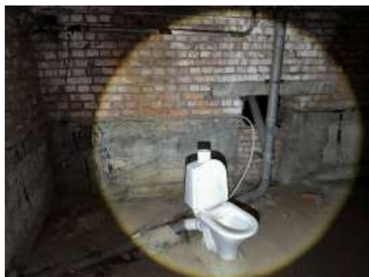
Фото № 11 – Внутреннее состояние помещения
