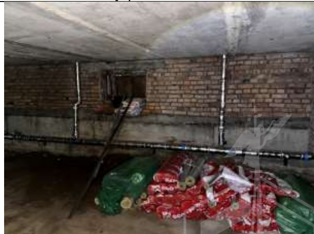
Фото № 16 – Внутреннее состояние помещения
