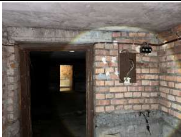
Фото № 19 – Внутреннее состояние помещения
