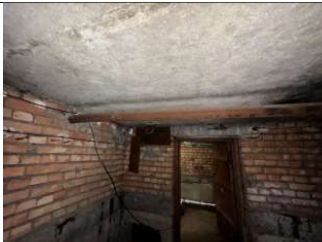
Фото № 17 – Внутреннее состояние помещения
