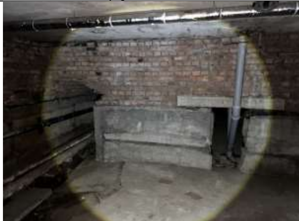
Фото № 20 – Внутреннее состояние помещения
