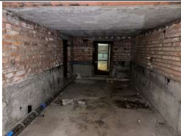
Фото № 9 – Внутреннее состояние помещения
