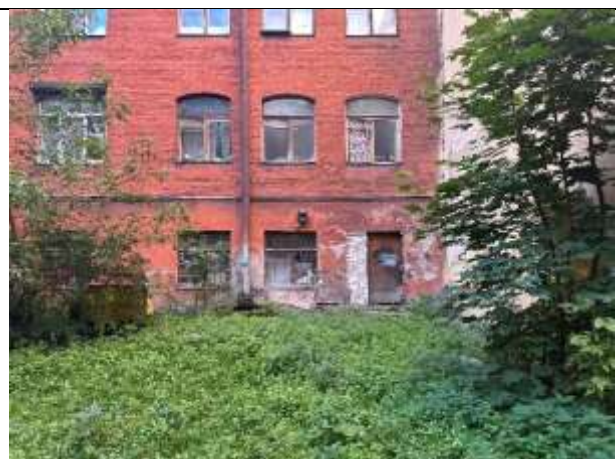
Фото № 8 – Вход в помещение со двора
