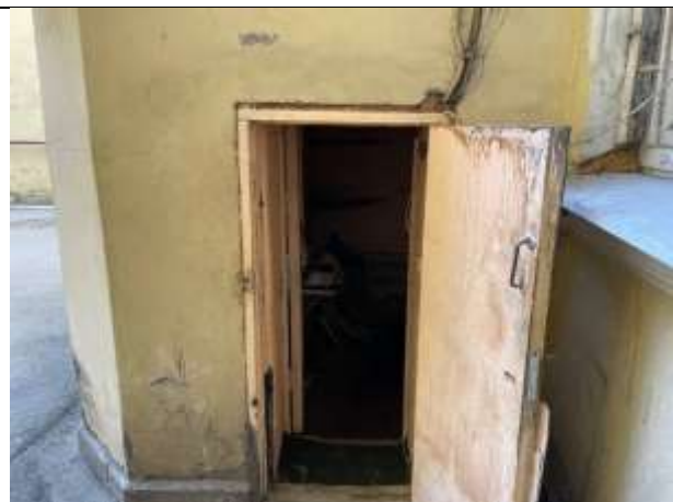
Фото № 8 – Вход в помещение со двора
