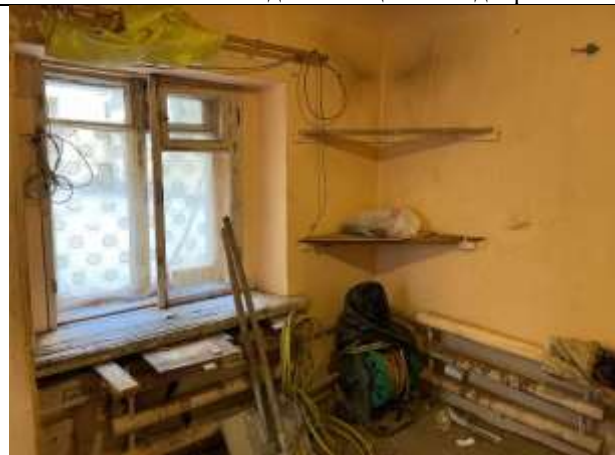
Фото № 10 – Внутреннее состояние помещения
