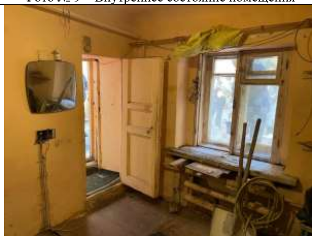
Фото № 11 – Внутреннее состояние помещения
