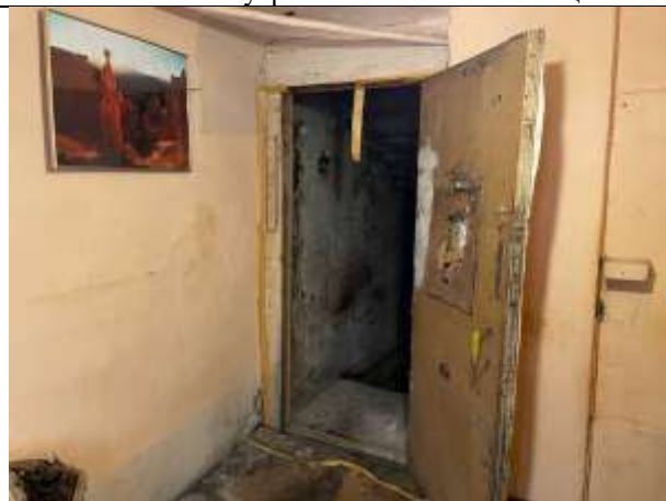
Фото № 13 – Внутреннее состояние помещения
