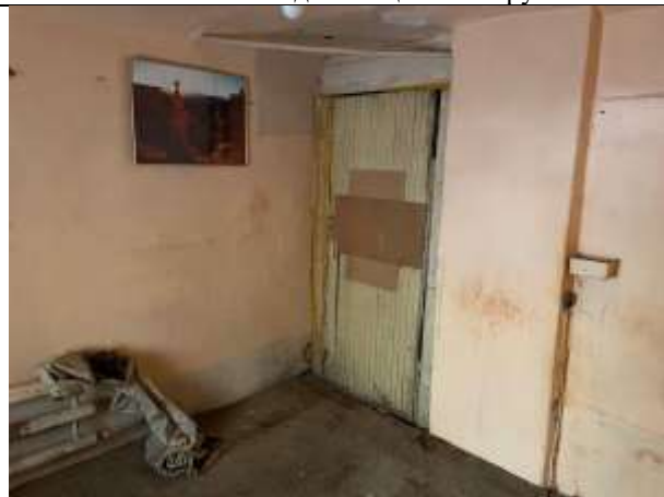
Фото № 9 – Внутреннее состояние помещения
