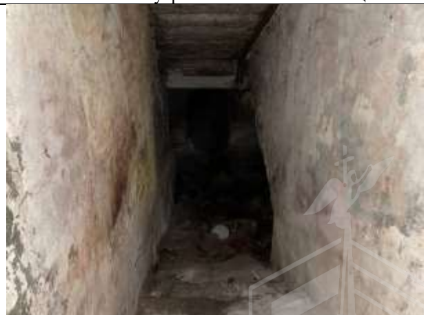
Фото № 14 – Спуск в подвал из помещения
