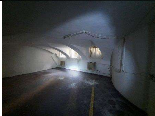
Фото № 13 – Внутреннее состояние помещения
