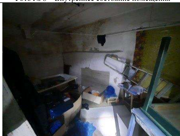
Фото № 10 – Внутреннее состояние помещения
