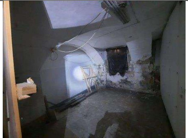
Фото № 14 – Внутреннее состояние помещения
