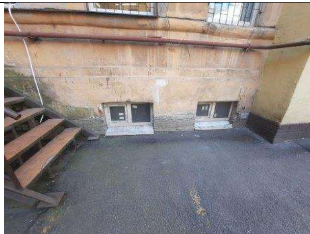
Фото № 6 – Окна помещения
