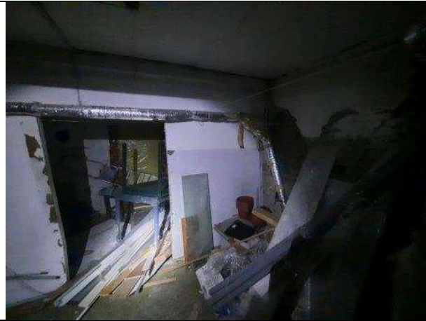
Фото № 21 – Внутреннее состояние помещения
