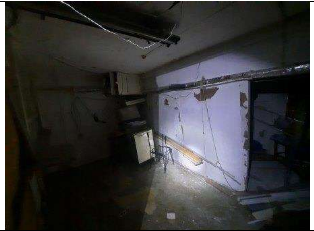
Фото № 22 – Внутреннее состояние помещения
