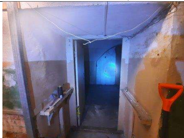
Фото № 8 – Внутреннее состояние помещения
