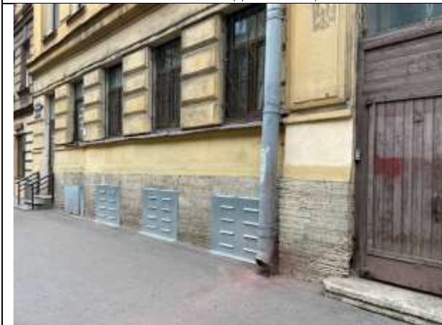
Фото № 7 – Окна помещения
