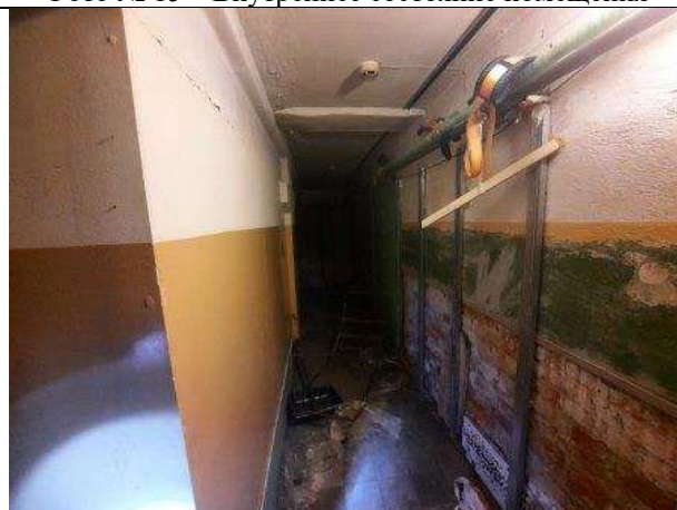
Фото № 17 – Внутреннее состояние помещения
