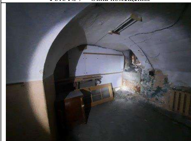
Фото № 9 – Внутреннее состояние помещения
