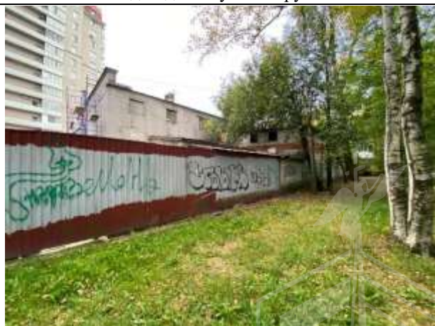
Фото № 4. Внешний вид здания
