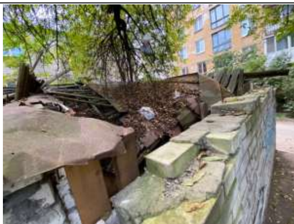
Фото № 13. Внутреннее состояние здания
