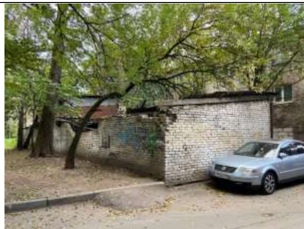
Фото № 10. Внешний вид здания
