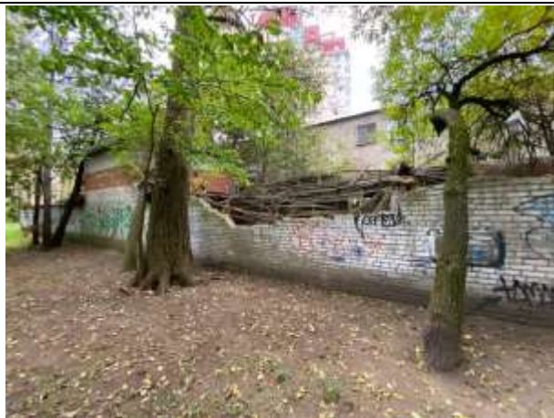
Фото № 7. Внешний вид здания
