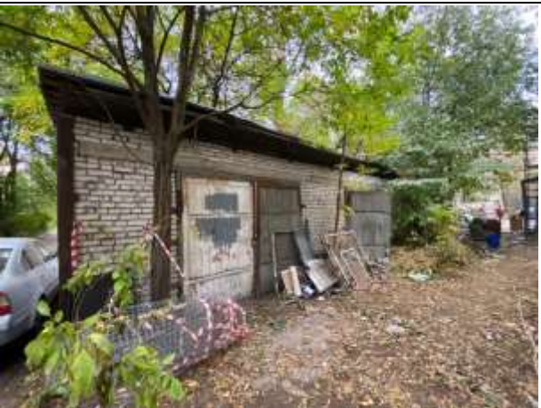
Фото № 8. Внешний вид здания
