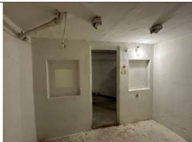
Фото № 14 – Внутреннее состояние помещения
