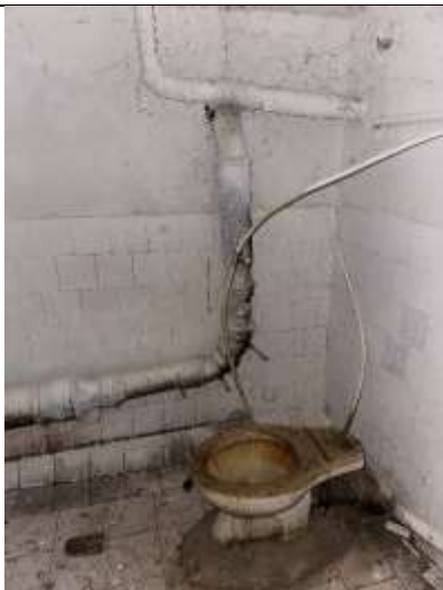
Фото № 19 – Внутреннее состояние помещения
