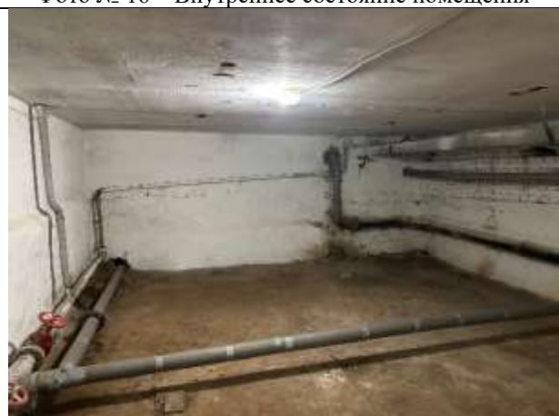
Фото № 18 – Внутреннее состояние помещения
