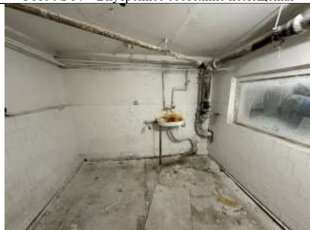
Фото № 16 – Внутреннее состояние помещения
