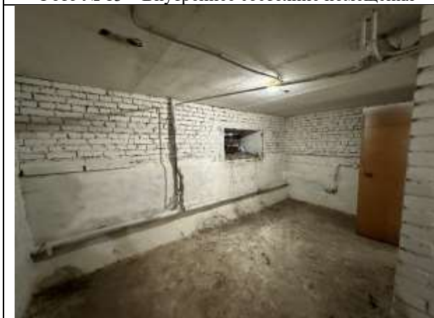
Фото № 15 – Внутреннее состояние помещения
