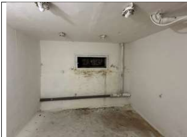
Фото № 13 – Внутреннее состояние помещения
